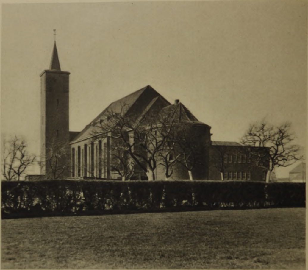
Gesamtbild der Kirche mit Blick gegen Chor und Sakristei
