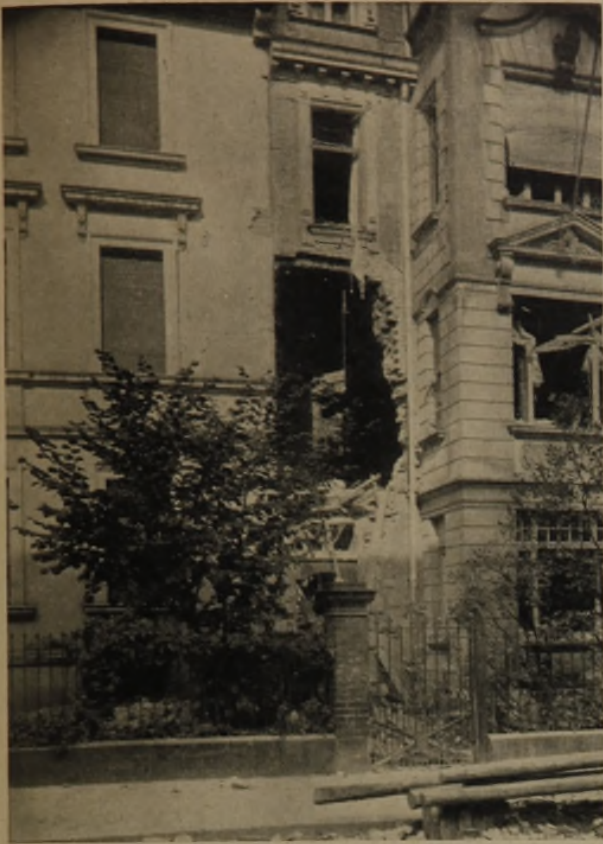
6 u. 7 Sprengbomben-Wirkung auf viergeschossiges, massives Wohnhaus
