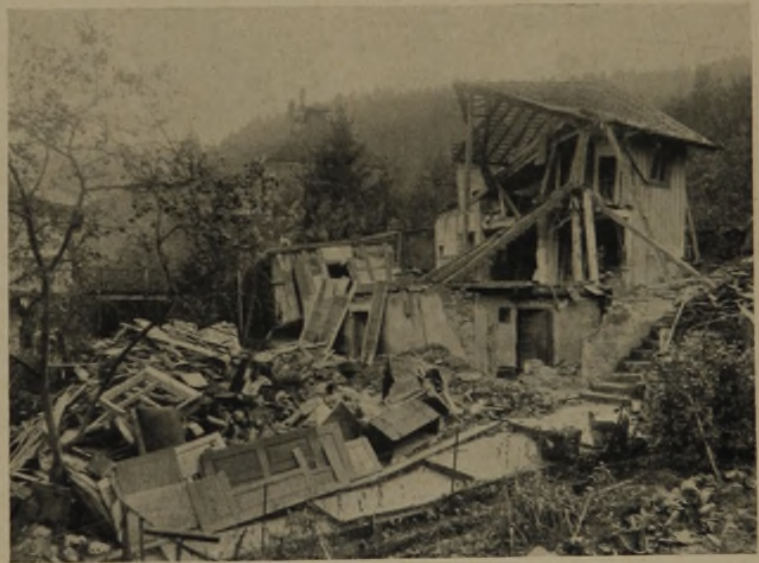
9 Sprengbomben-Wirkung auf alten Fachwerkbau
