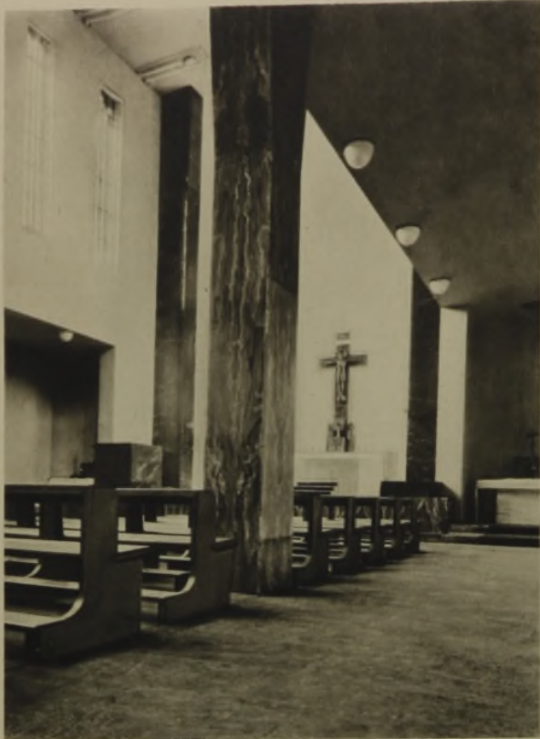
Durchblick vom Seitenschiff zum Hochaltar Die Eisenstütze mit Saalburger Marmor umkleidet
