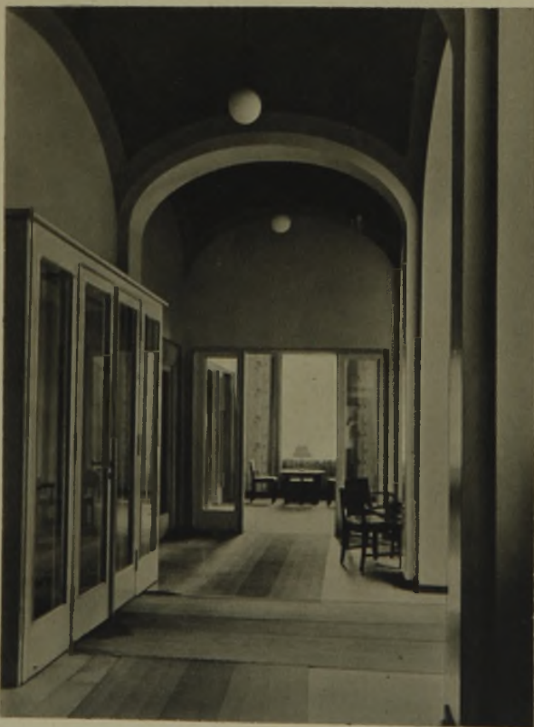
11 Umbau im Nordflügel des Kurhauses Neue Hotelhalle mit Eingang
