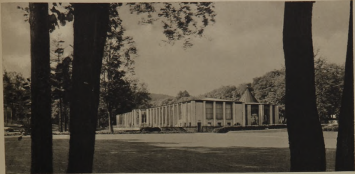
5 Quellen- und Wandelhalle für Salz- und Moritzquelle, Außenansicht
