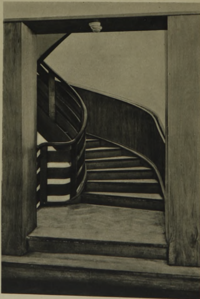
13 Zugang von der Gaststube im Erdgeschoß zur Wendeltreppe
