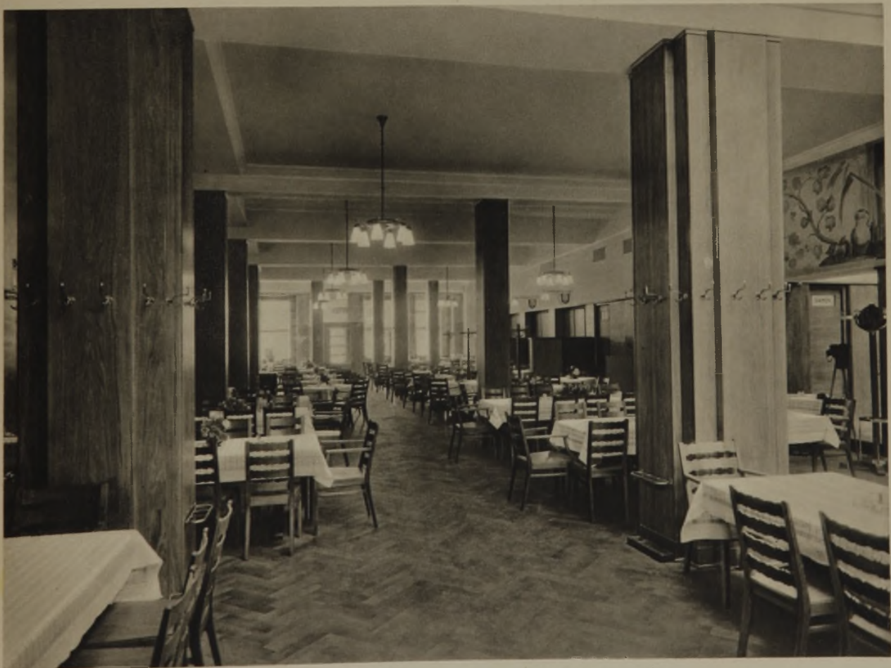
11 Hauptraum im Erdgeschoß. Blick nach der Residenzstraße
