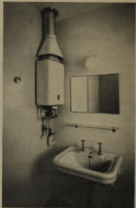
5 (links) Der Gasheizofen als Zusatzheizer für Übergangszeit und Heizspitzen. Neuzeitliche Form, vorschriftsmäßiger Einbau
