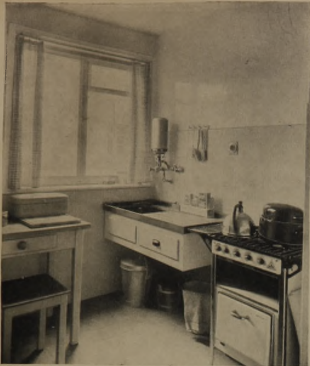
1 (oben links) Gasherd und Gaskleinwasserheizer Neuzeitliche Bauform — vorschriftsmäßig eingebaut
