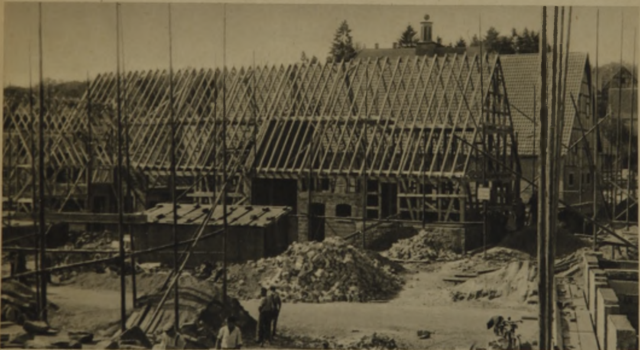
7 Fachwerk - Aufrichten in alemannischer Bauweise
