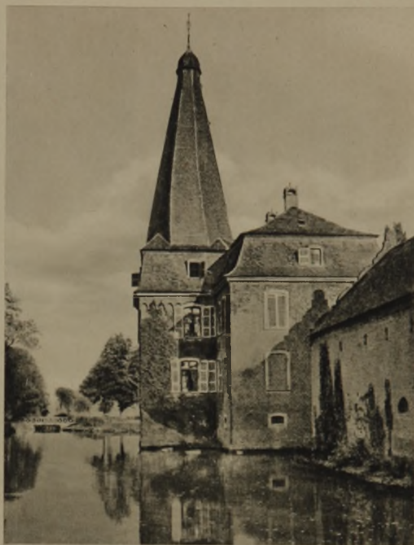
2 (rechts) Niederrhein-Wasserschloß vor Erneuerung des Turmes
