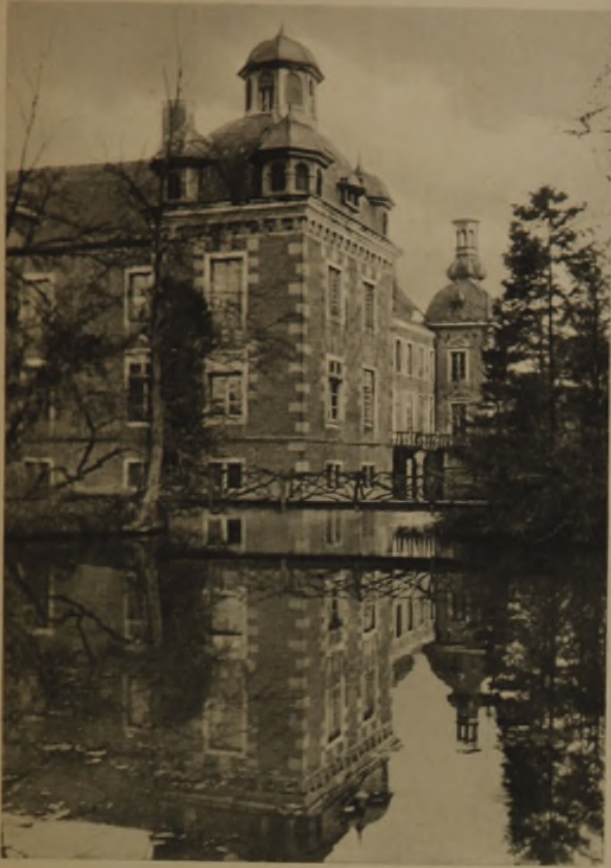
6 Schloß Velen kurz vor dem Brand Unterhaltungszustand nicht gut, eine obere Turmhaube fehlte bereits ganz
