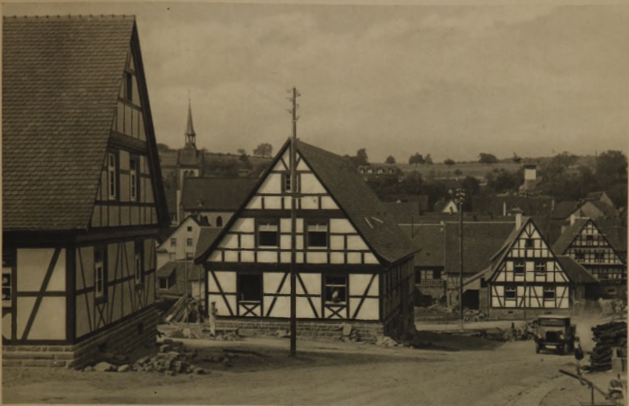
6 Bauerngehöfte in alemannischer Bauweise (in der Steiggasse, Blick gegen Norden). Wohnraum, Stall und Scheune unter einem Dach
