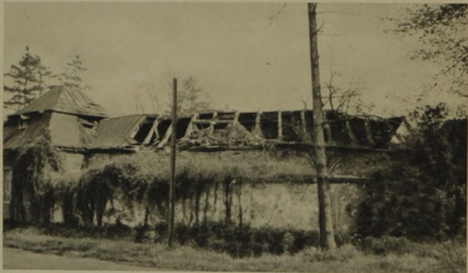
11 Eines der größten westfälischen Wasserschlösser. In den Nebenanlagen ein unwürdig ruinöser Zustand
