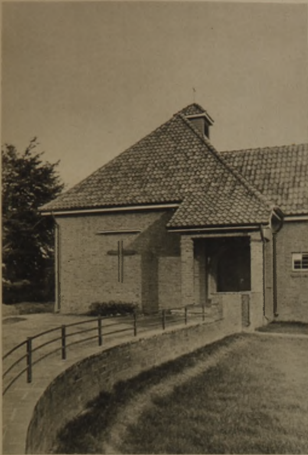
14 Eingang zum Gemeindehaus
