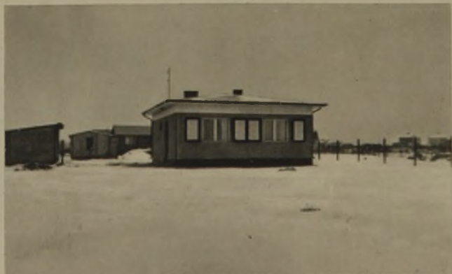
Zustand vor dem Umbau Ohne Architekt gebaut
