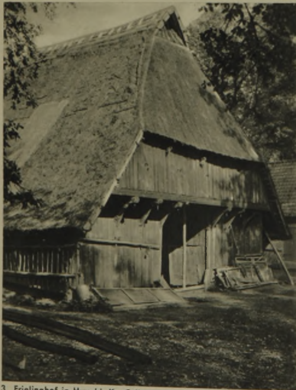
3 Frielinghof in Huxahl, Kr. Celle Eichenholzschwerk mit starker Vorkragung und besonders großen Holz- nägeln. Seit 700 Jahren im Besitz des Erbhof-Bauerngeschlechts Frieling Zeit der Erbauung um 1700
