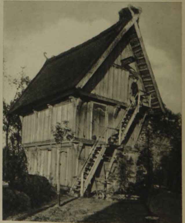
4 Treppenspeicher mit 2 Treppen an der Giebelseite
