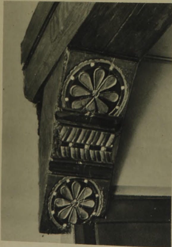
9 und 10 (unten) Kopfbänder am Flettbalken mit reichem Kerbschnittwerk Bauernhöfe in Oeningen, Kr. Soltau
