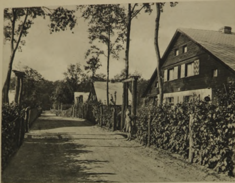
Links: Blick in Straße des Bauabschnitts I
