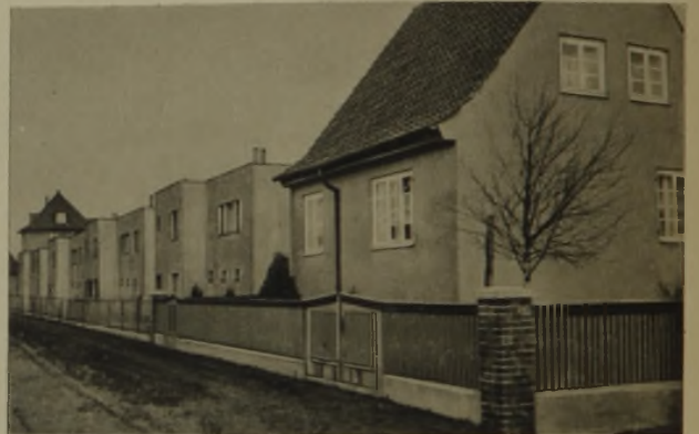
5 Ausfüllen einer Baulücke zwischen Steildächern mit Flachdach Eine grobe Verunstaltung des Ortsbildes. Wie wird nun richtiger weitergebaut, mit Sattel- oder Walmdach?
