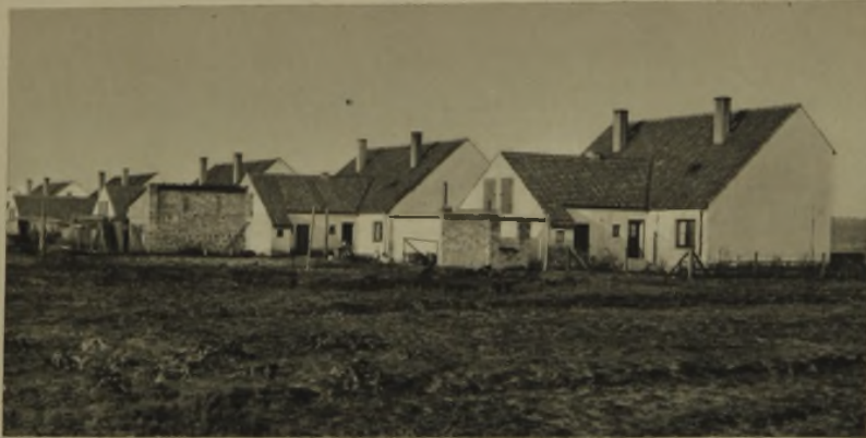
15 und 16 Dieselbe Kleinstsiedlung aus der Landschaft gesehen Durch Selbsthilfebauten ist der Eindruck zerstört
