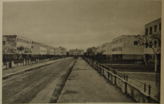
3 Siedlungsabschnitt mit Flachdächern Wurden in wenigen Jahren unbrauchbar und mußten mit Steildach versehen werden
