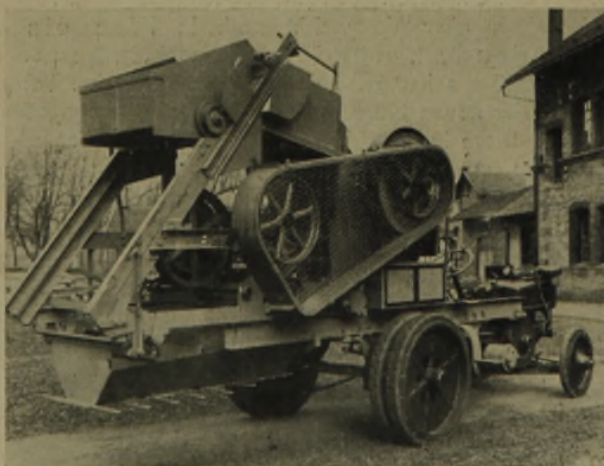
4 Auto-Steinbrecher. Das Hüttenwerk Sonthofen hat sich aus einem Diesel-Straßenschlepper und einem normalen Steinbrecher diesen äußerst leistungsfähigen Auto-Steinbrecher hergestellt
