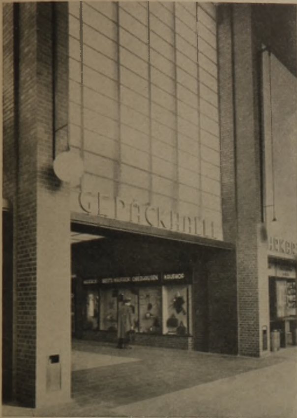
4 Stahl im Empfangsgebäude des Bahnhofs Oberhausen Fenster, Auslagen, Beleuchtungskörper und Papierbehälter aus Stahl
