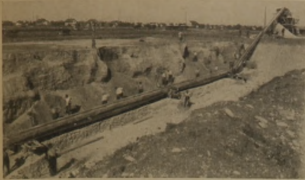
2 Zusammenstellung von Gurtförderern die beim Bau der Reichsautobahnen Verwendung finden
