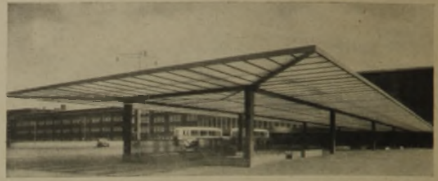
3 Vorplatzüberdachung in Stahl und Glas
