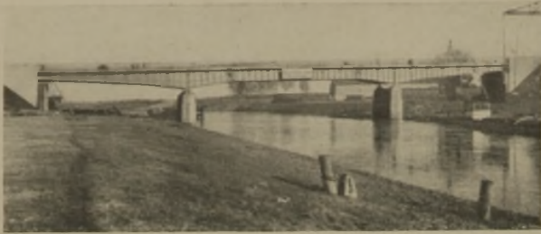
2 Geschweißte Brücke bei Verden
