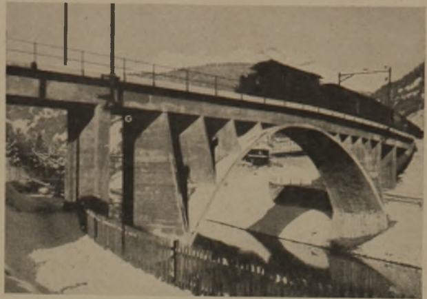
4 Landquartbrücke der rhätischen Bahn in Klosters
