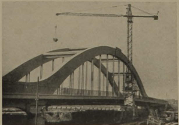
5 Eisenbeton-Bogen-Brücke mit angehängter Fahrbahn über die Kinzig bei Kehl
