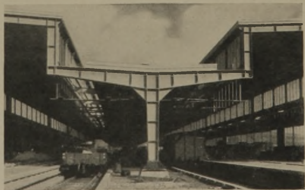
5 Geschweißte Bahnsteighallen auf dem neuen Hauptbahnhof in Düsseldorf
