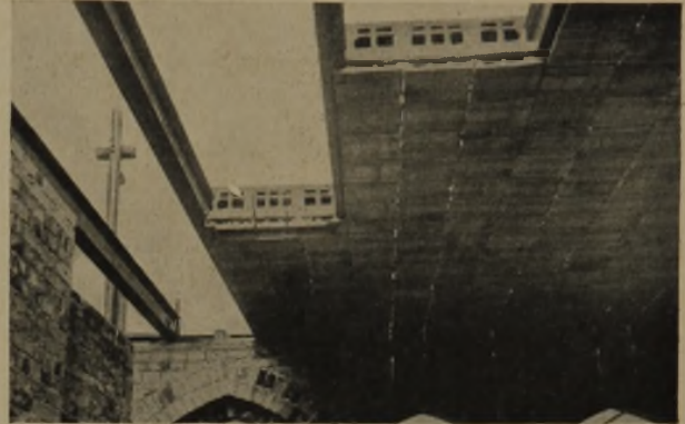
3 Hoyer-Massivdecke, die neue Eisenbeton-Verbund-Konstruktion
