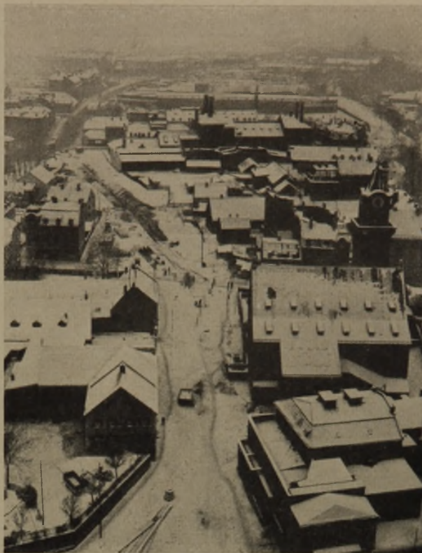
7 Durchbruch der Ichostraße von der Giesinger Bergstraße zur Tegernseer Landstraße. Blick vom Turm der Giesinger Kirche nach Süden auf die neue Ichostraße und die Lutherkirche von Grössl
