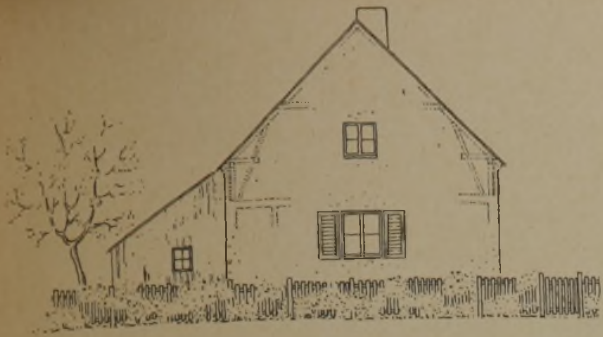
6 Ein Siedlerhaus in zweistufigem Ausbau (Typ C 101). Straßenansicht der ersten Ausbaustufe.
