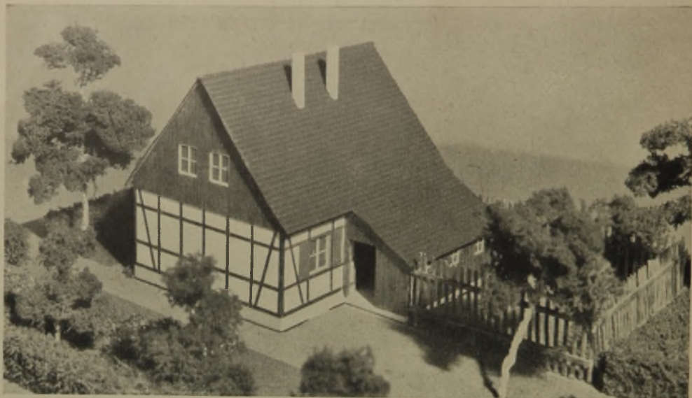
11 Typ C10. Hauskörper, der in seinem vollen Umfang sofort gebaut und durch Innenausbau im Dachgeschoß den Anforderungen der wachsenden Familie gerecht wird 1)
