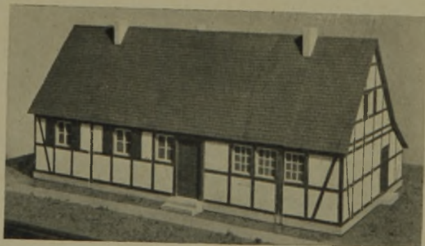
4 Dritte Ausbaustufe. Anbau am Wirtschaftsflügel und Durchbau des vorderen Stallteiles mit einer Werkstatt. Gleichzeitig ist eine Erweiterung des Anbaues unter dem abgeschleppten Dach vorgenommen. (Rückansicht gibt Abb. 1 auf der vorigen Seite.)
