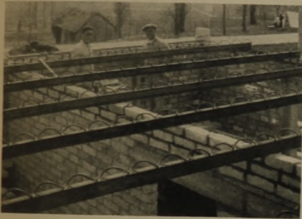
2 u. 3 Anwendung der Alpha-Konstruktion im Deckenbau
