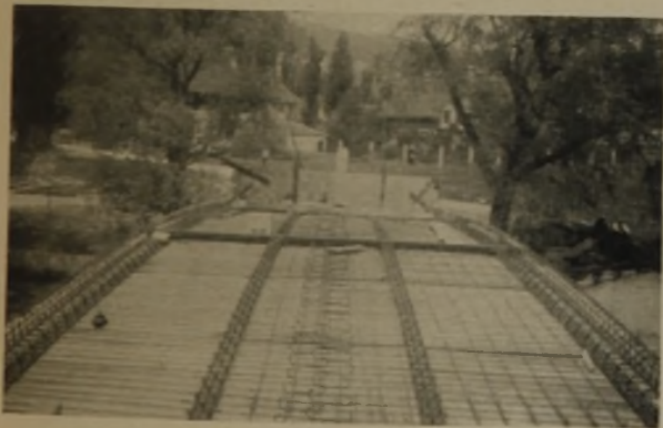
4 u. 5 Anwendung der Alpha-Konstruktion für die Fahrbahntafel einer Straßenbrücke
