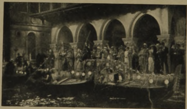
10 Der ausgeführte Bau während des Spiels
