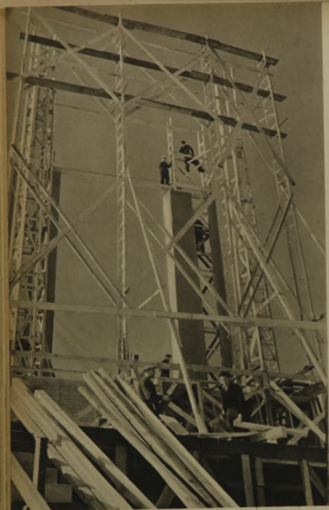
Gerüst für die Errichtung der Säulen des Hafentores
