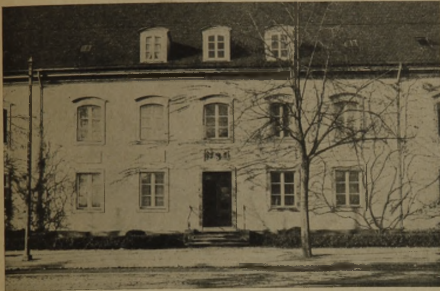
1 Bauleistung aus den Jahren 1920/22. Zeitnahe Gestaltung durch Architekt Heinrich Kaiser mit guter Einfühlung und Anpassung an den Potsdamer Stadtgeist
