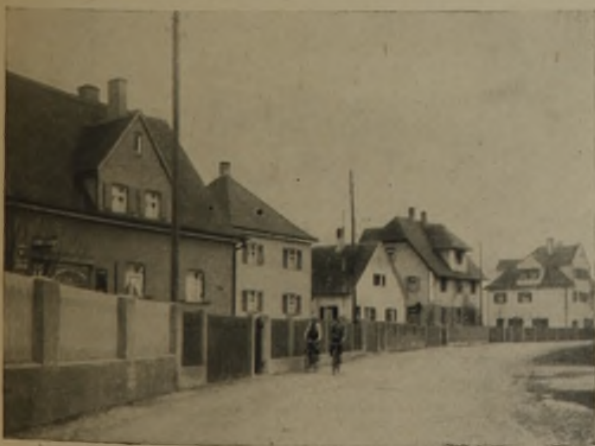
2 Unruhiges Straßenbild, hervorgerufen durch Verschiedenheit von Bauhöhe, Dachform, Dachneigung, Firstrichtung und durch die willkürlichen Baufluchten (Augsburg—Hochzoll-Süd)
