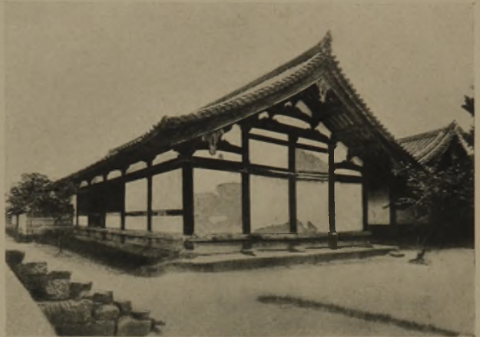
1 Teil des Horyuji-Tempels bei Nara, ursprünglich Wohnung einer Frau Tachibana, erbaut 739 n. Chr.
