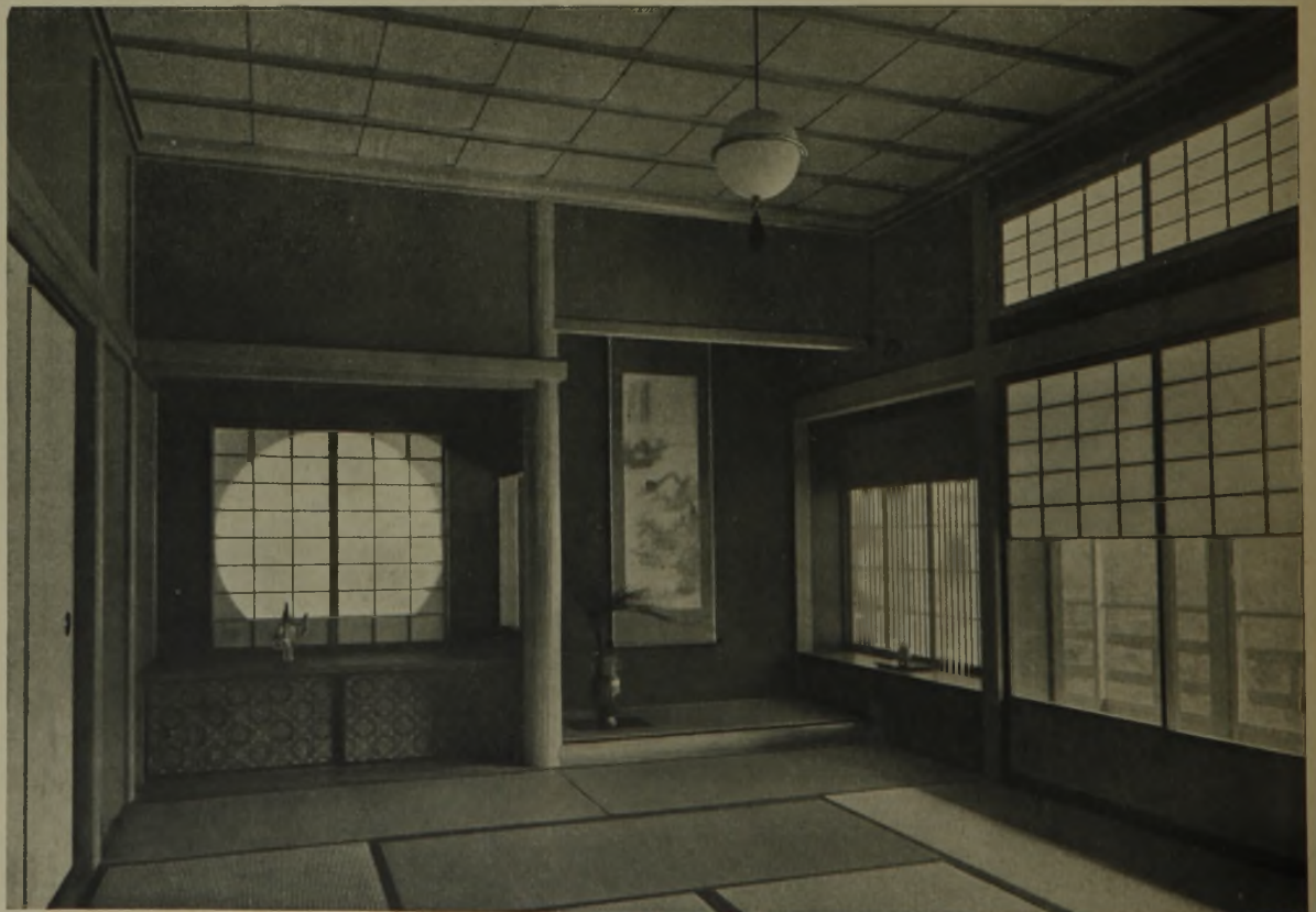
7 Wohnzimmer. Bauholz ist durchweg Sugiholz. Als Tokoposten und Tokoschwelle sind polierte Naturstämme aus Sugiholz verwendet
