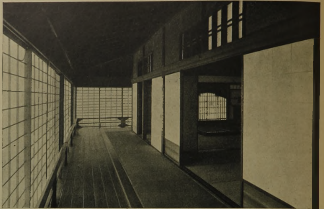
3 Im Kaiserlichen Katsura-Palast (dritter Bauabschnitt). Veranda vor den Wohnzimmern — teils gedeckelt, teils mit Matten belegt
