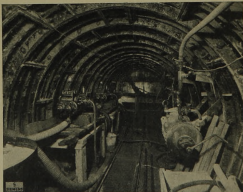
2 Ausführung der Verfestigungsarbeiten an der Haltestelle Monument Links die Druckpumpen zum Einpressen der beiden chemischen Stoffe, rechts ein Zementpreßkessel zum Hinterpressen der Tübbings mit Zement
