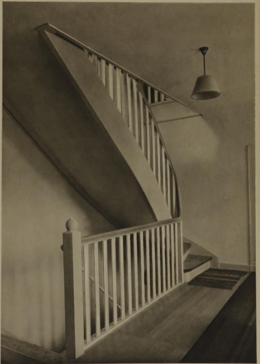
Treppenhaus im Neubau
