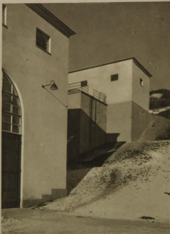
Einfahrt zur Maschinenhalle und Blick auf das Wasserschloß
