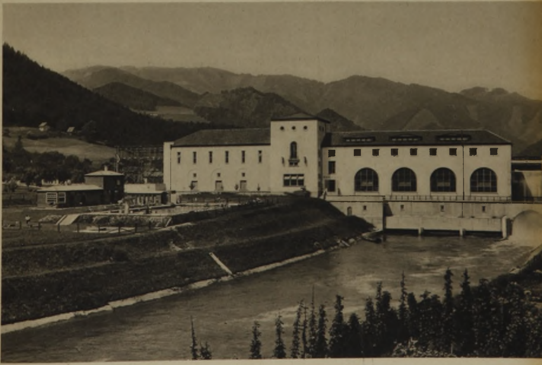
Ansicht des Kraftwerks Pernegg gegen den Stromlauf
