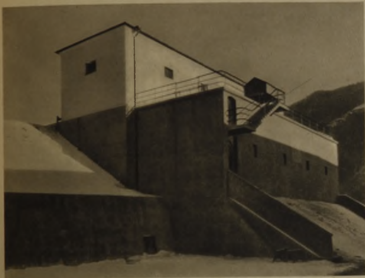
Das Wasserschloß des Werkes Mixnitz-Frohnleiten
