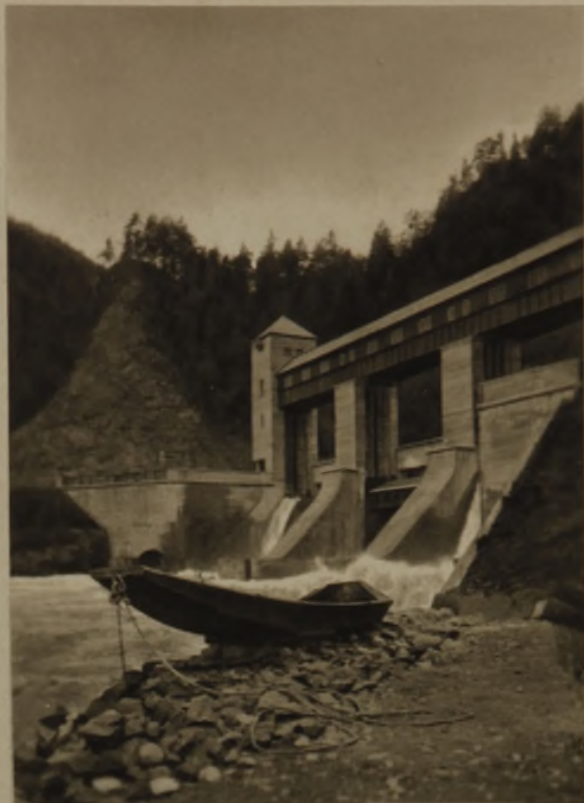
Blick auf das Wehr Pernegg vom Damm gegen den Turm
