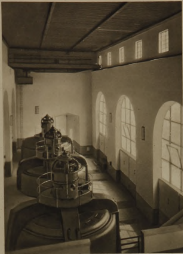
Inneres der Maschinenhalle
