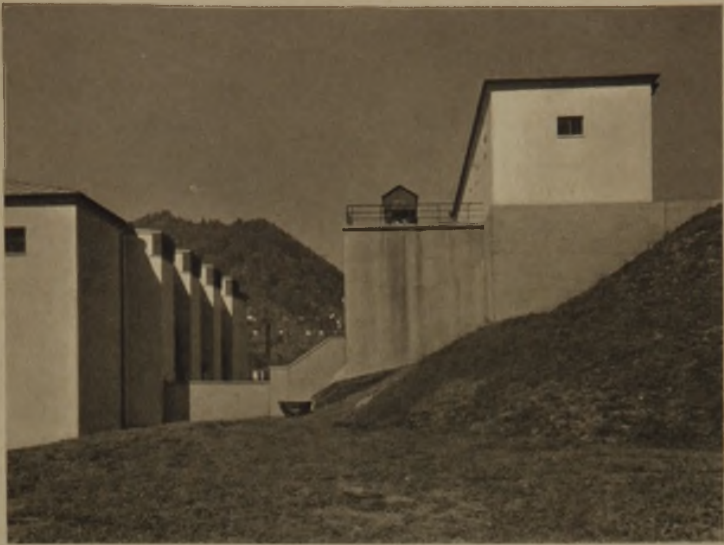
Das Wasserschloß (rechts) und die Frischluftzuführung (links) an der Rückwand des Krafthauses
