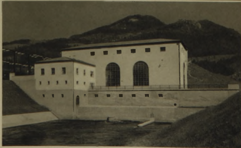
Maschinenhalle des Werkes
