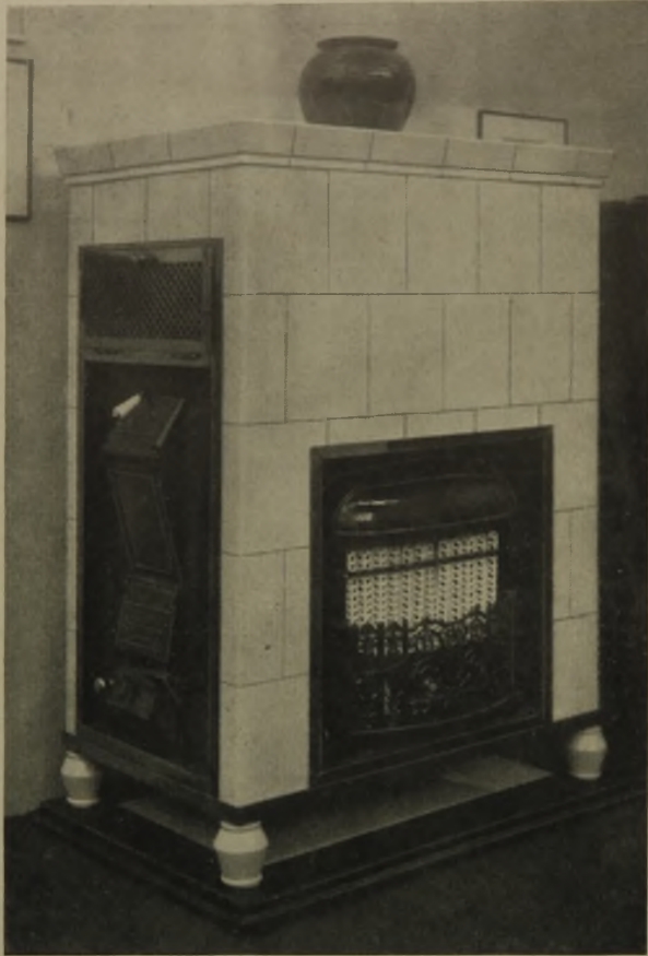
3 Kachelofen mit Dauerbrandeinsatz und Gasheizkörper (für Übergangszeiten)
