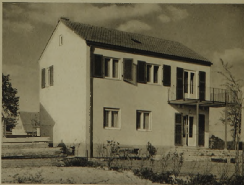
Einfamilienhaus aus der Siedlung
