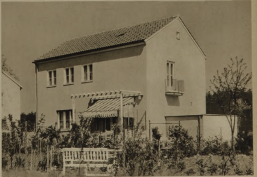
Haus Plinke, Gartenansicht
