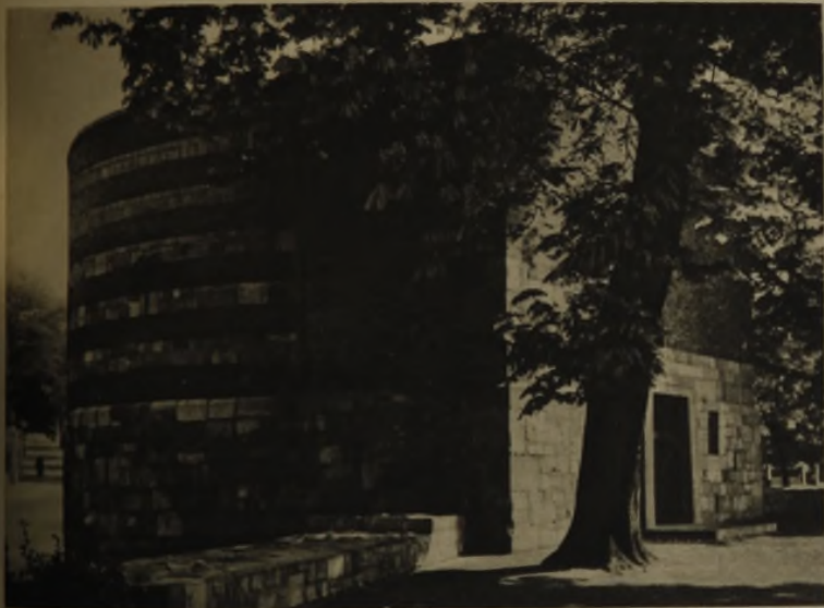
Das Äußere des Marienurms der alten Stadtbefestigung
