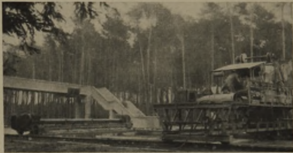
4 3,75 m breiter Fertiger. Trennung von Führungsschiene und Schalbalken
