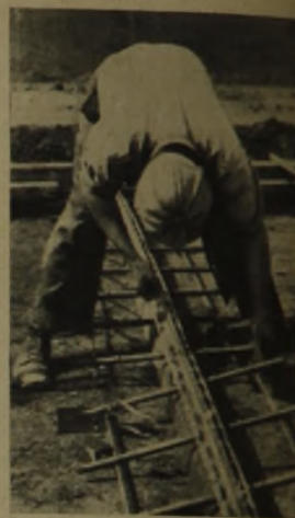
8 Zu schwierige Fugenausbildung: Amerikanische „Luftkissenfuge“ mit Kupferdichtung
