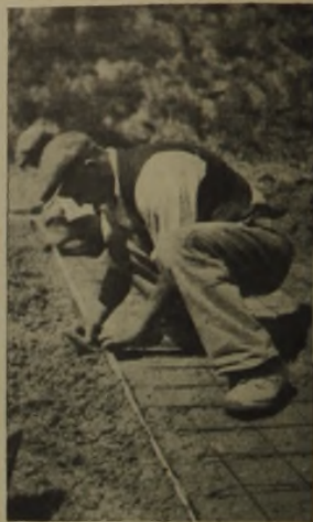
7 Für die Fugen ist der gewissenhafte Facharbeiter nicht zu entbehren
