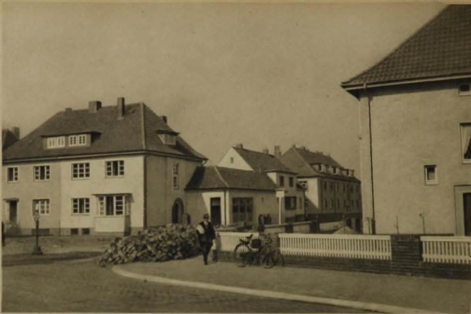
15 Es müssen bald entschiedene Wege beschritten werden, damit neu erschlossene Baugebiete nicht so beginnen wie hier
