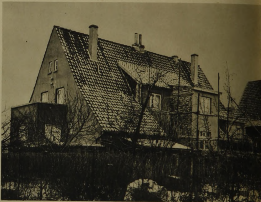
4 Gewissenlos verändert ein Bauritter „ohne Furcht und Bauschein“ ein einheitlich gestaltetes Doppelhaus, dessen weithin sichtbare Rückseite wichtiger ist als die Vorderseite
