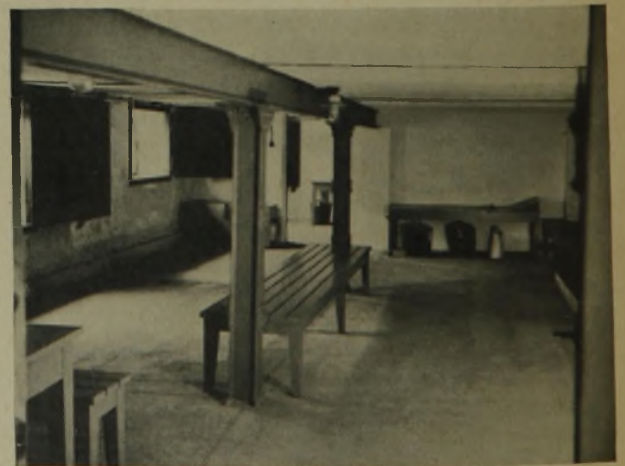
7 Unterbau. Ausführung in Eisen. Links an der Wand eine geschlossene und eine geöffnete Fensterblende
