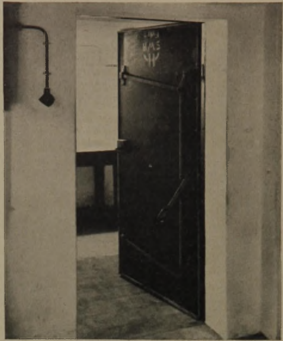
3 Gasdichte Tür aus Eisenblech. Splittersichere Türen müssen aus 15-25 mm starkem Eisenblech hergestellt sein
