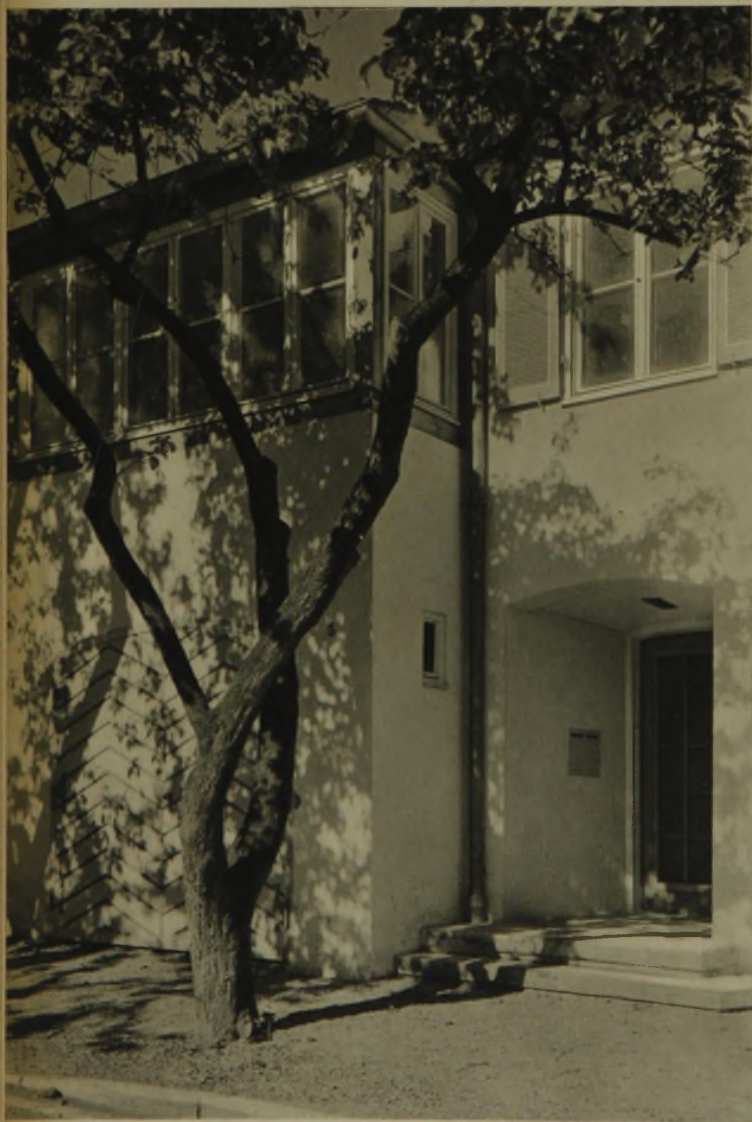
Der Eingang mit Erker und Einfahrt zum Einstellraum
