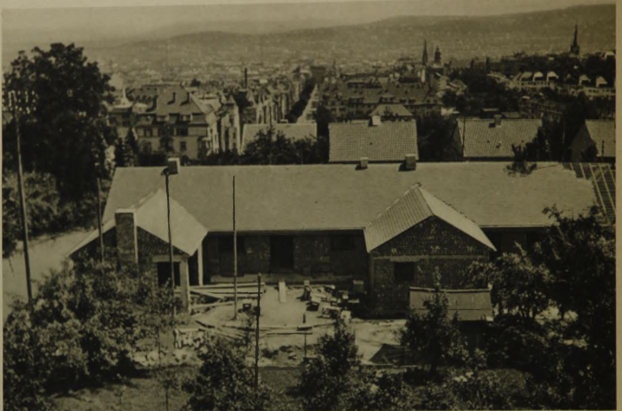
Blick vom Hang auf die Gartenseite der Atriumhäuser im Bauzustand
