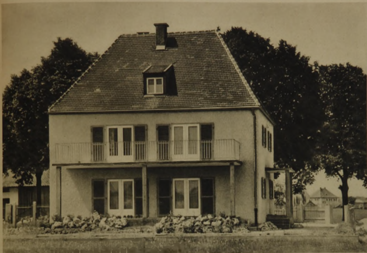
Haus Näger. Ansicht des Zweifamilienhauses vom Garten
