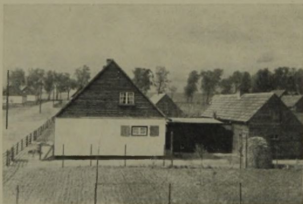
3 Dietrich-Eckart-Siedlung der Hirsch-Kupfer- und Messingwerke in Finow, erbaut 1934
