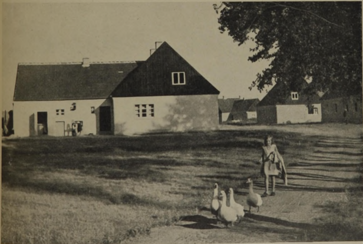
1 Vorstädtische Kleinsiedlung Frankfurt an der Oder, erbaut 1934
