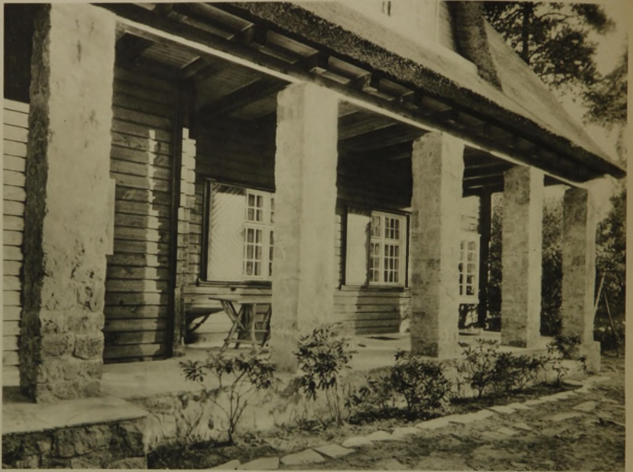
Die Pergola. Schönes Zusammenwirken der Baustoffe: Kalksteinpfeiler — Holzwandungen — Rohrdach
