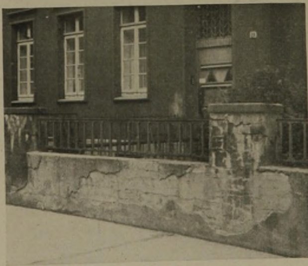
9 Bauherr und Volkswirtschaft können verlangen, daß Architekt und Ausführender das Handwerkliche ihrer Arbeit sorgfältiger überlegen, als es in diesem Beispiel geschehen ist
