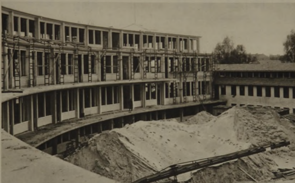
Das im Bau befindliche Wirtschaftsgebäude. Blick in den Innenhof. Links Hauptgebäude, rechts Anschluß des Seitenflügels
