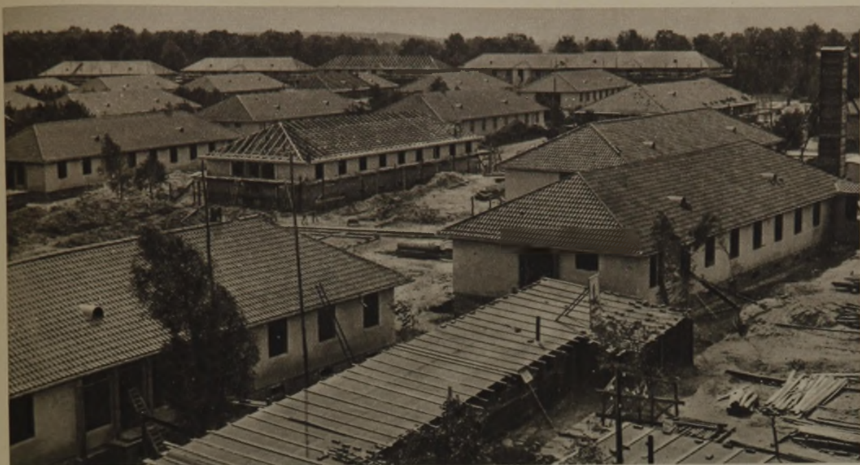
Übersicht über einen Teil der Wohnhäuser in verschiedenen Bauzuständen
