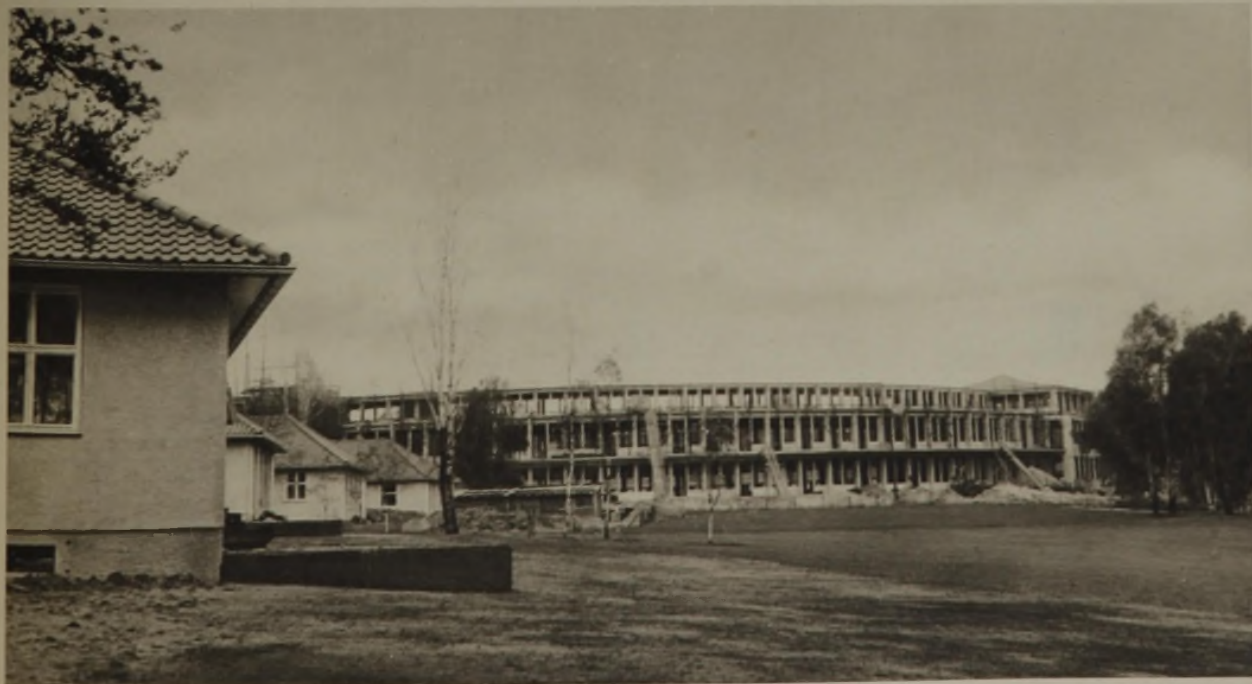
Unten: Blick von einer Wohnhausgruppe auf die Gartenseite des Wirtschaftsgebäudes
