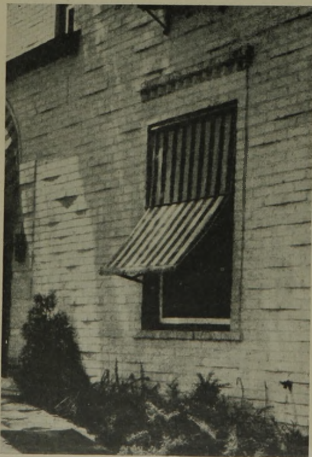
11 und 12 Backsteinkunststücke, die dem Mauerwerk sehr gefährlich werden können, weil sie die Zerstörung der wichtigen Außenhaut erleichtern. Das Handwerkliche wird damit geradezu verhöhnt
