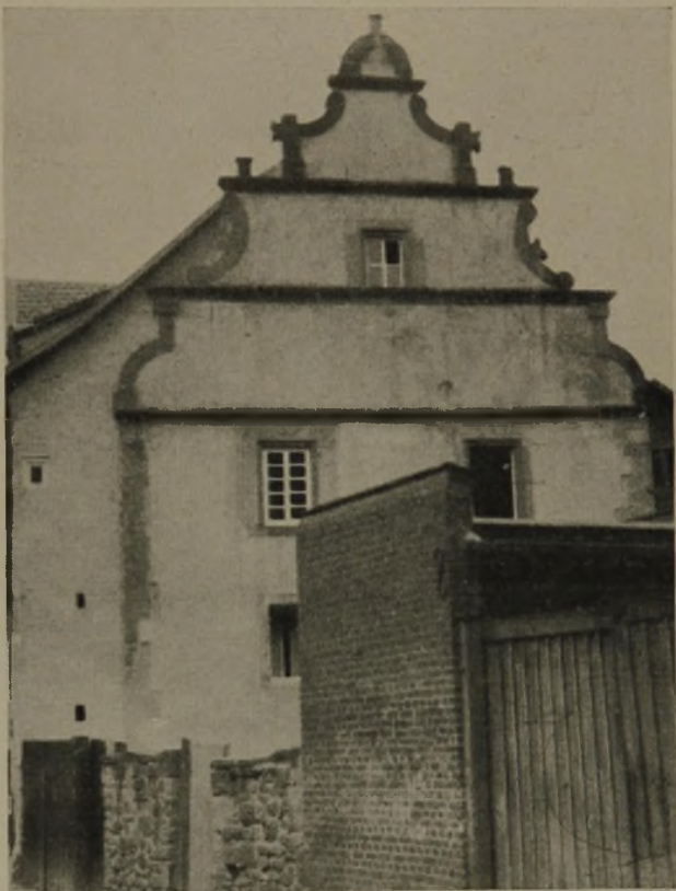
1 Steinmetzarbeit, die den Stein abwegig in Holzformen behandelt. Der handwerklich jammervolle Anbau, der sich in die Vorderfläche des Giebels drängt, stammt natürlich aus der Zeit völligen handwerklichen Verfalles
