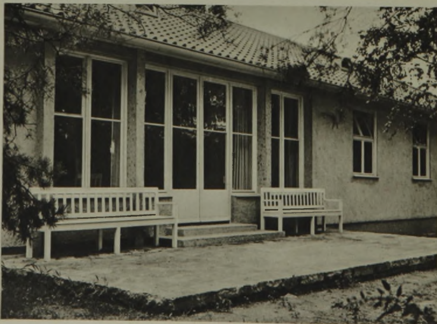
Gartenseite mit Eingang zum Tagesraum
