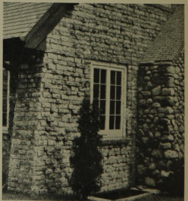
11 und 12 Backsteinkunststücke, die dem Mauerwerk sehr gefährlich werden können, weil sie die Zerstörung der wichtigen Außenhaut erleichtern. Das Handwerkliche wird damit geradezu verhöhnt
