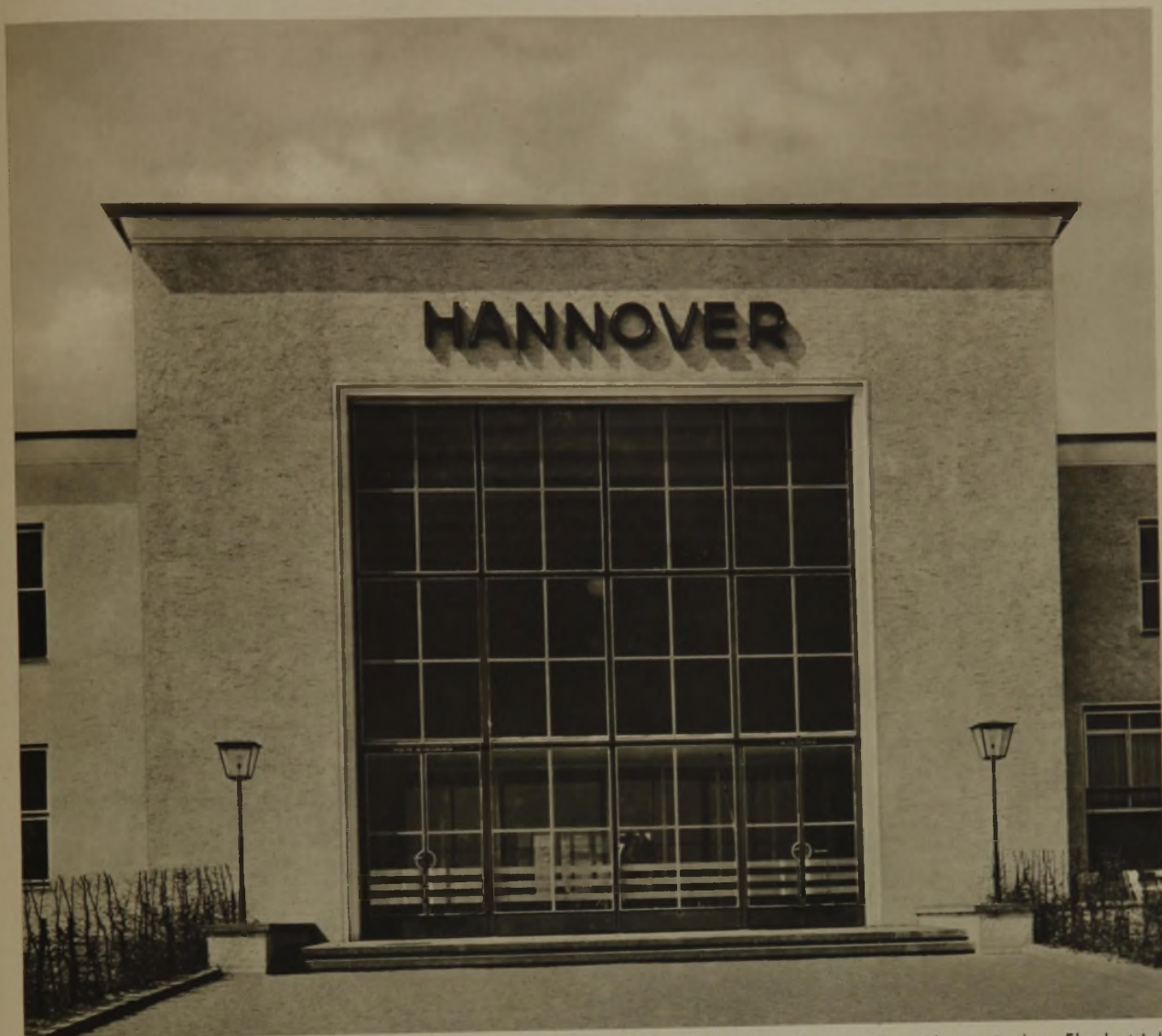
Ausgang zum Rollfeld. Die große Öffnung verbindet den Raum aufs stärkste mit dem Flugbetrieb
