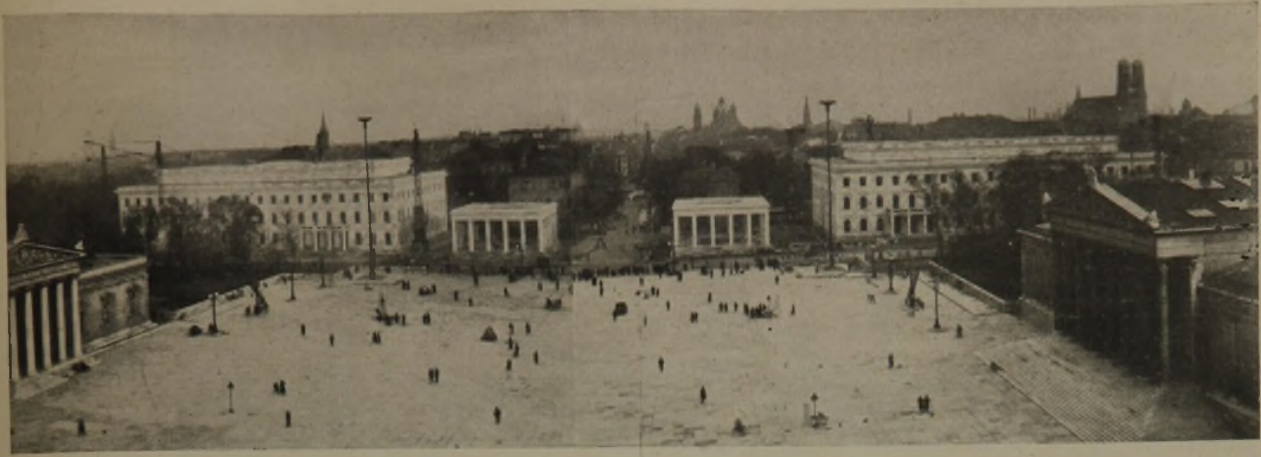
4 Blick auf den Königsplatz vom Dach der Propyläen. Von links: Glyptothek, Führerhaus, die Ehrentempel, Parteihaus, Staatsgalerie
