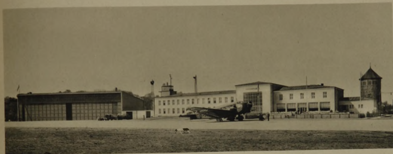
Blick vom Rollfeld auf das Empfangsgebäude und die Flugzeughalle
