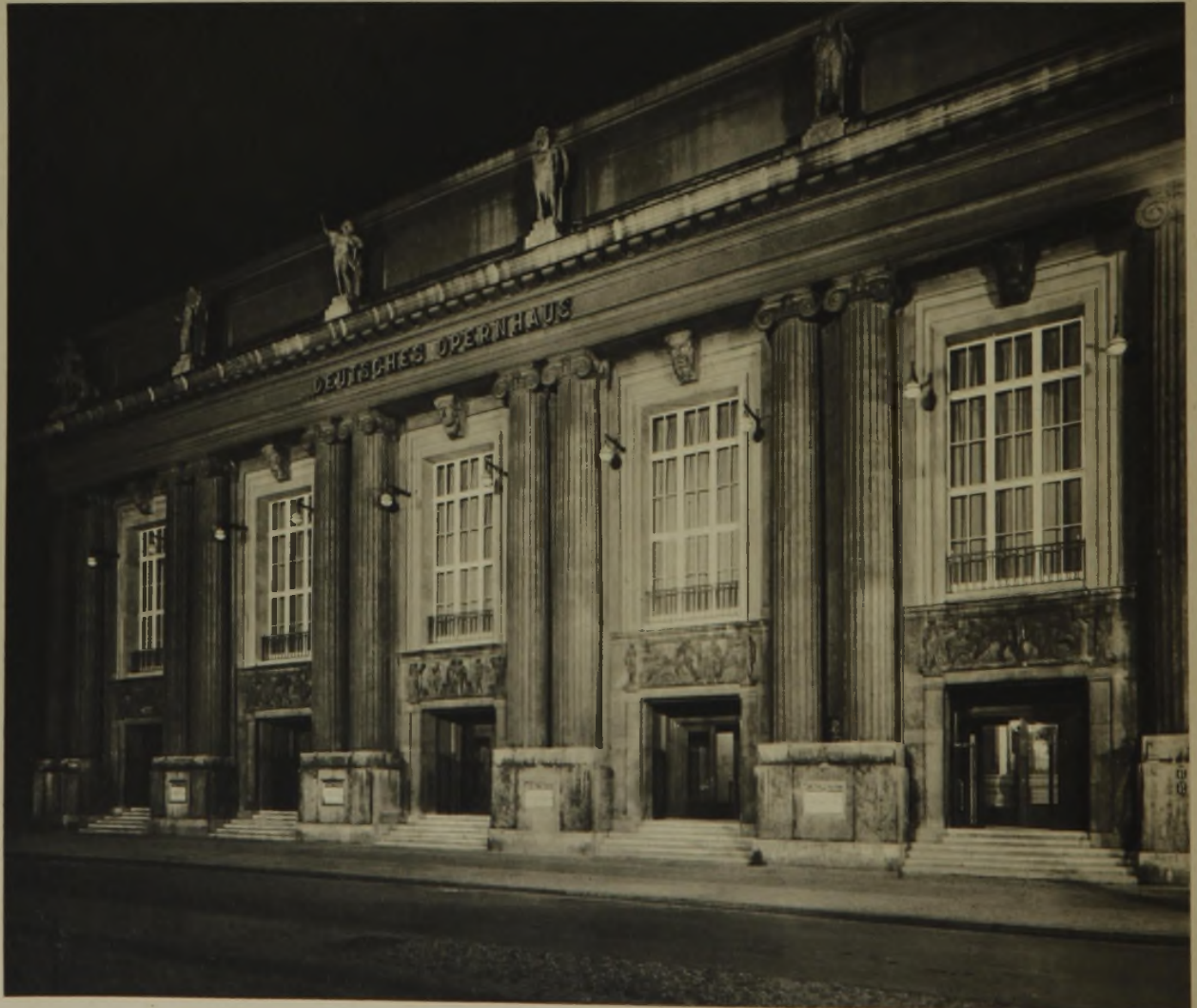
Nachtaufnahme der Eingangsseite mit den neugestalteten Fenstern der Wandelhalle
