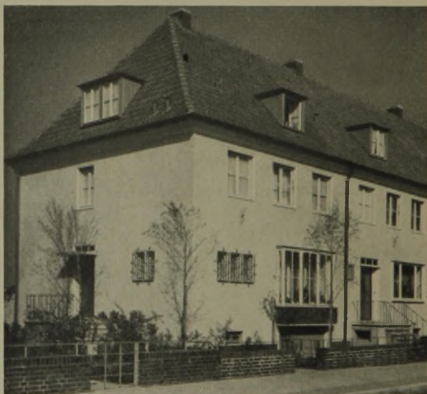
3 Einfamilienhausgruppe in Hannover, Aachener Straße. Der Putz, dem bunter Flußkies beigegeben wurde, ist gekratzt
