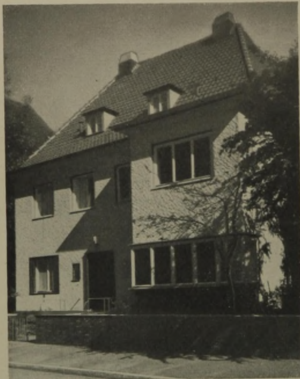
1 Einfamilienhaus in Hannover, Waldhausenstraße. Straßenseite. Der Putz ist mit der Kelle nach einer bestimmten Richtung angeworfen und nicht weiter behandelt
