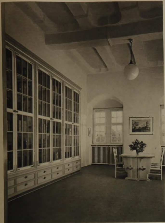
Les- und Schreibzimmer mit alter Decke
