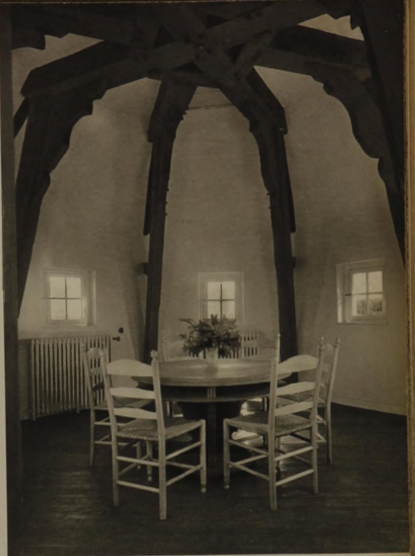
Turmzimmer mit freigelegtem Balkenwerk
