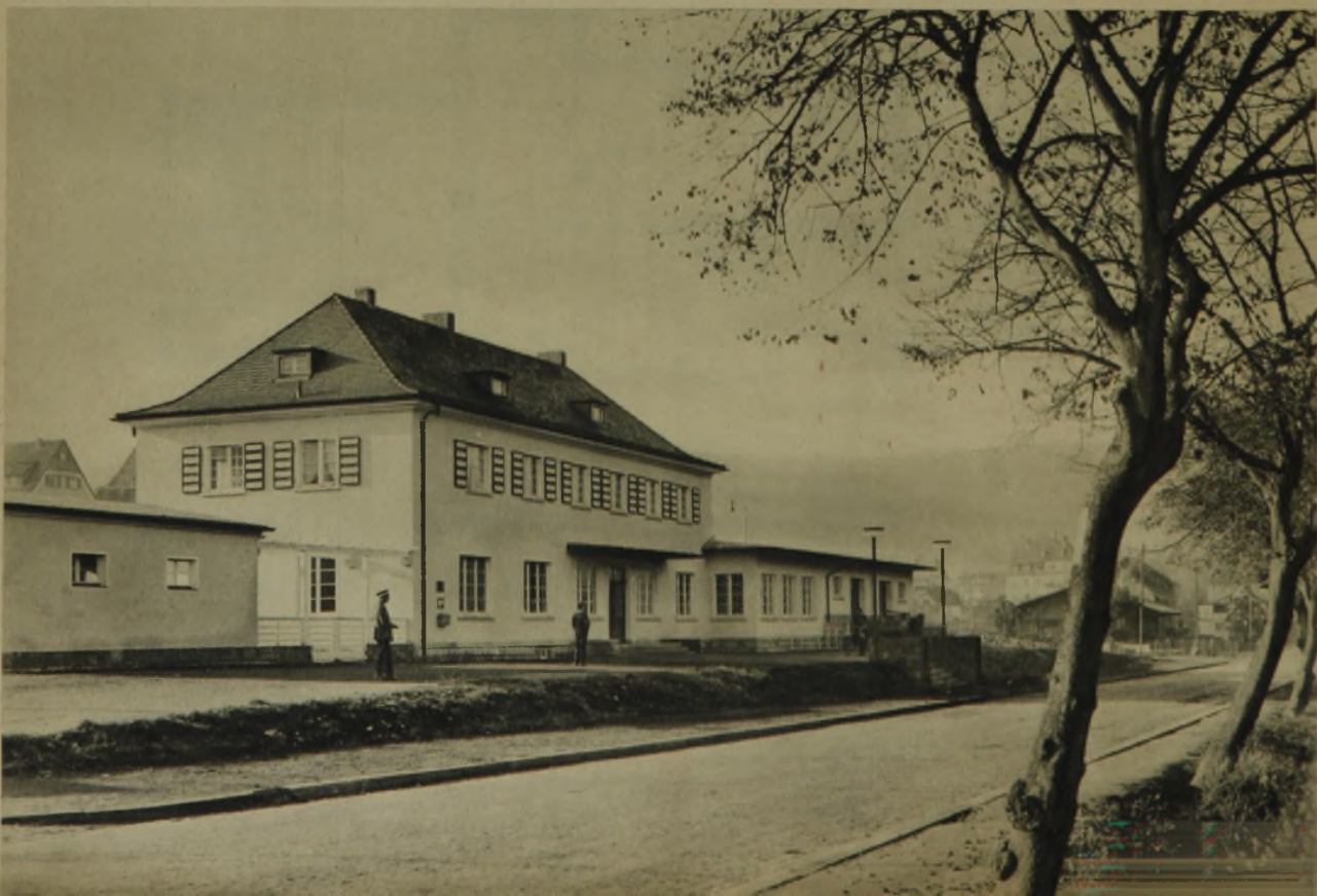
Brückenaustadt, Empfangsgebäude. Entwurf: Reichsbahndirektion Nürnberg (Reichsbahnoberrat Limpert)
