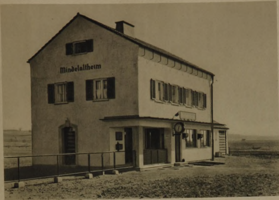
Mindelaltheim, Betriebsgebäude, Bahnseite. Entwurf: Reichsbahndirektion Augsburg
