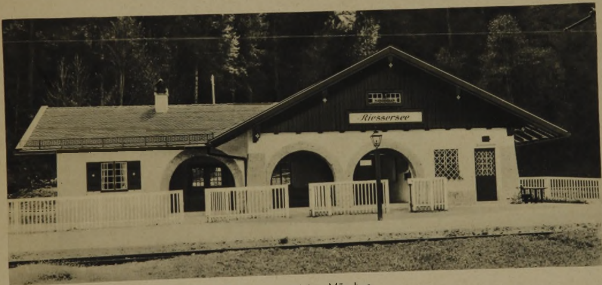
Riessersee, Empfangsgebäude. Entwurf: Reichsbahndirektion München
