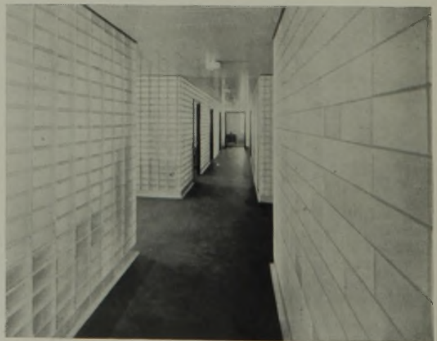
Nicht nur die Außenwände, sondern auch die Trennwände im Inneren des Gebäudes sind lichtdurchlässig mit Glasbausteinen aufgeführt
