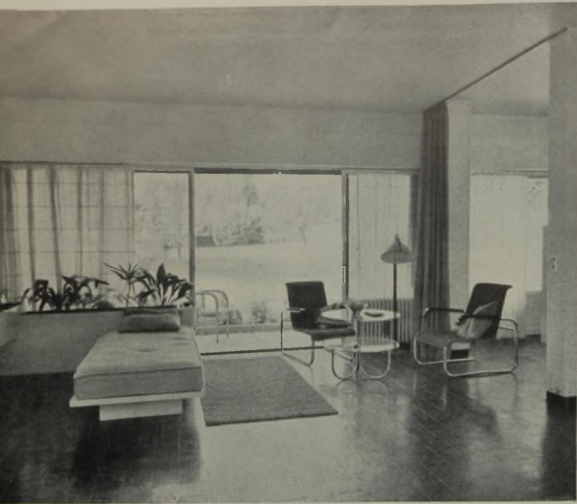
Haus Ville d'Avray (Frankreich). Eisenbetonbau mit offener, sehr heller Raumgestaltung. Architekt: André Lurçat. Links: Wohnraum mit Schiebefür. Unten: Erdgeschoß
