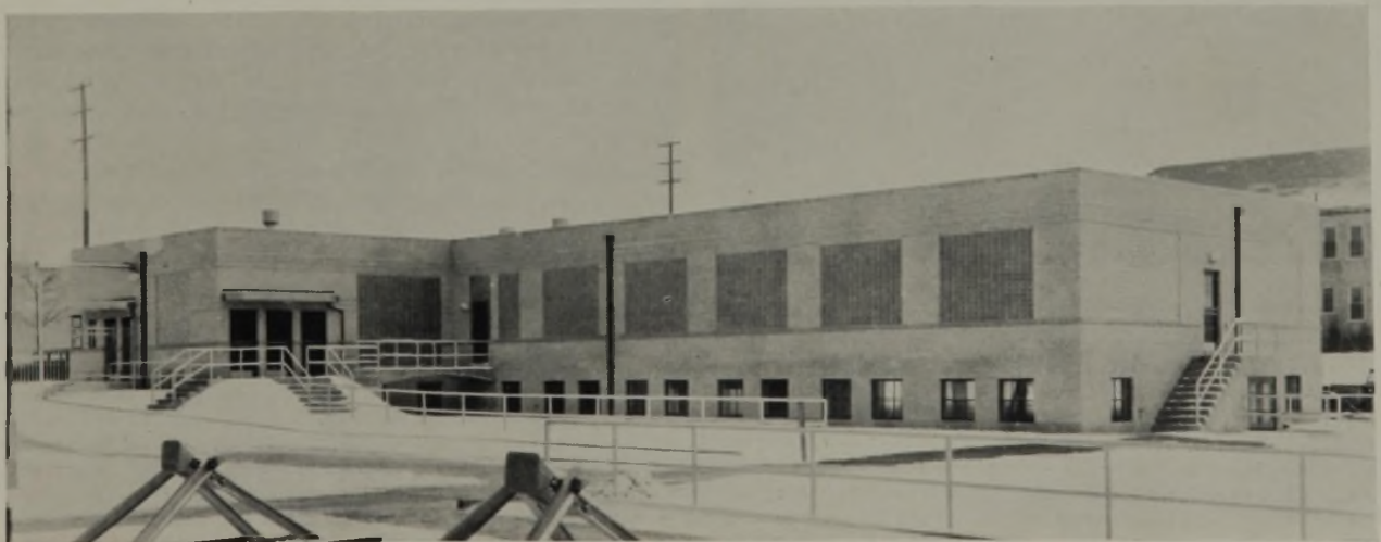
Einbau von großen lichtdurchlässigen Wandteilen aus Glashohlbausteinen bei einem Ziegelbau
