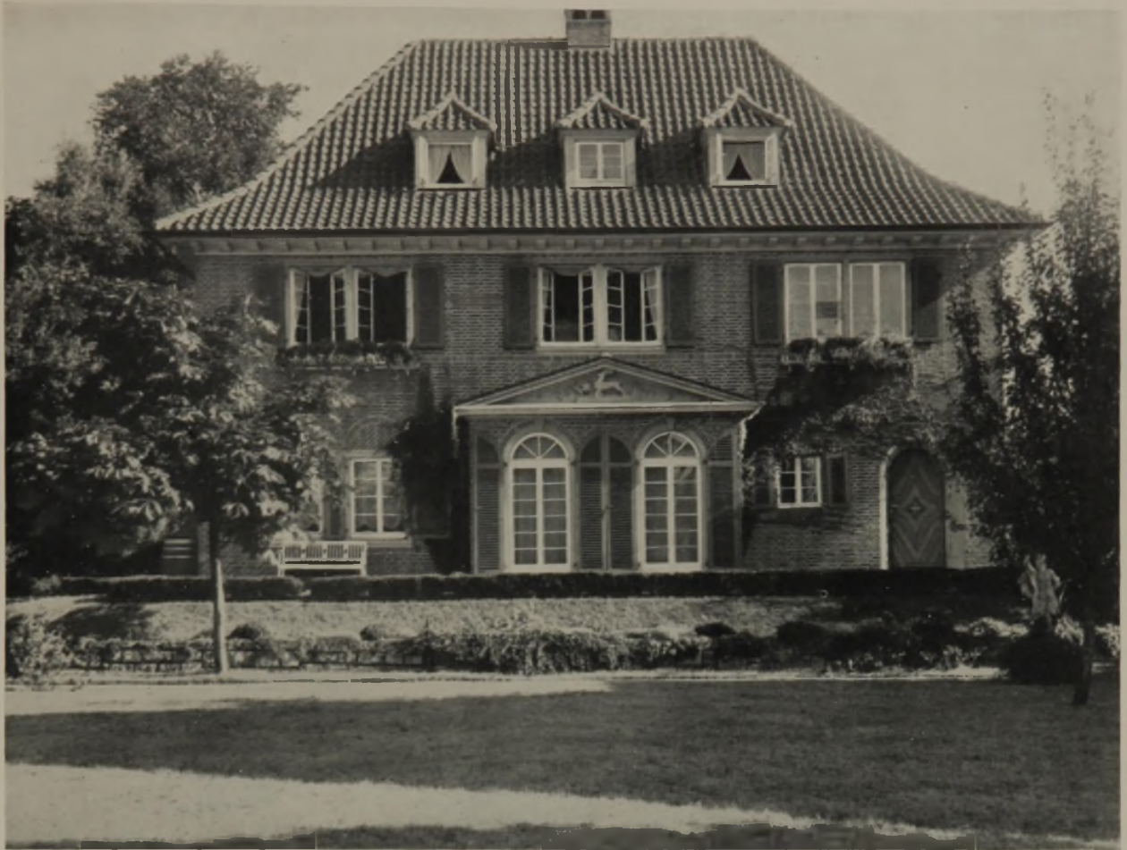
Wohnhaus R. J. Blick von Südwesten
