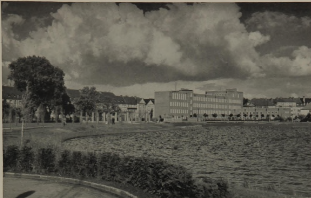
3 Das Südufer. Der im rechten Teil des Bildes beginnende Abschnitt wird eine streng geregelte Bebauung erhalten, damit die vorhandenen unschönen und unregelmäßigen Bauten verschwinden. Aufnahme: Walter Werner, Stendal
