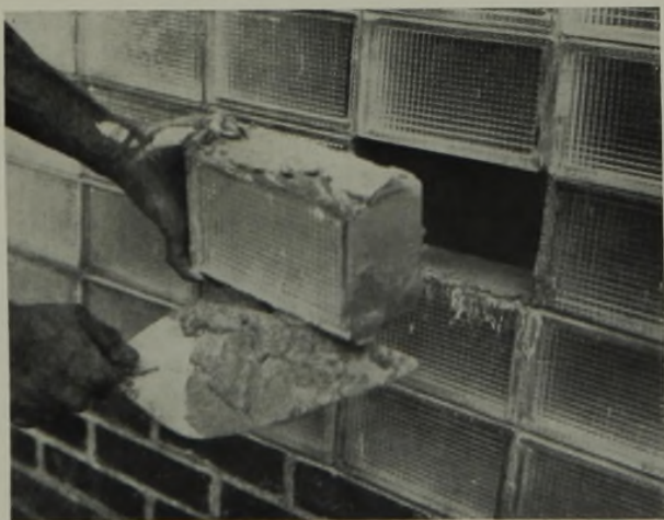
Einsetzen eines neuen Glashohlsteins
