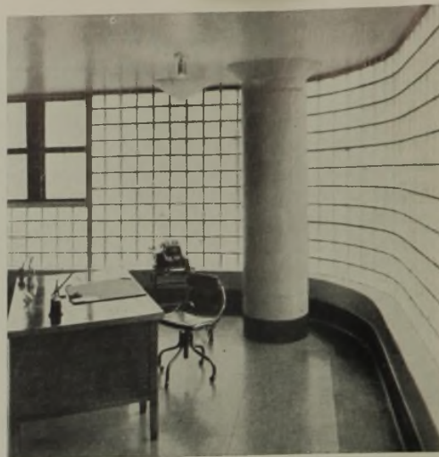
Das Innere des mit Fensteröffnungen ausgestatteten Glashohlsteinbaues. Die Außenwand wird stützenlos im Bogen an den Gebäudeecken herumgeführt
