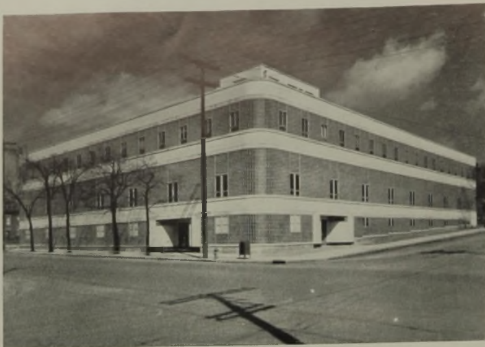
Hier ist die Glashohlsteinwand von durchsichtigen Fenstereinbauten unterbrochen. Es lassen sich unbedenklich Türen und Fenster in die Hohlsteinwände ohne Schwierigkeit einsetzen
