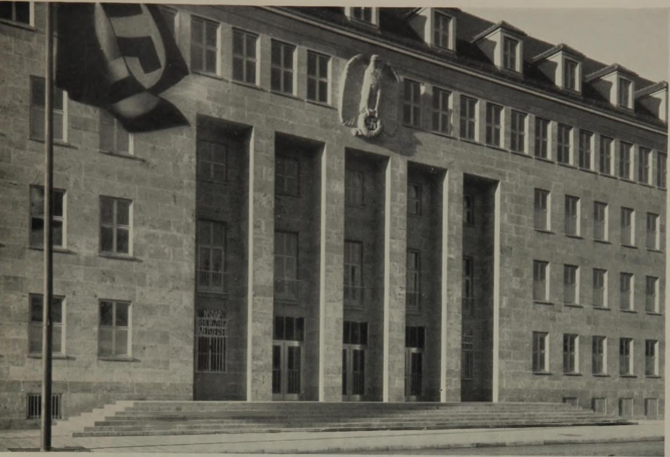
Die Reichszeugmeisterei ist im Frühjahr 1935 begonnen worden und konnte bereits im Herbst 1937 übergeben werden. Das Skelett des Baues ist aus Baustahl 37 und dem höherwertigen Baustahl 52 mit Kruppschen und MAN Doppelwinkeldecken und Doppelwinkeldachhaut. Als Füllmauerwerk sind Ziegel bzw. Wabensteine verwendet, für die Fußböden ist Parkett-Eichenriemen genommen.
