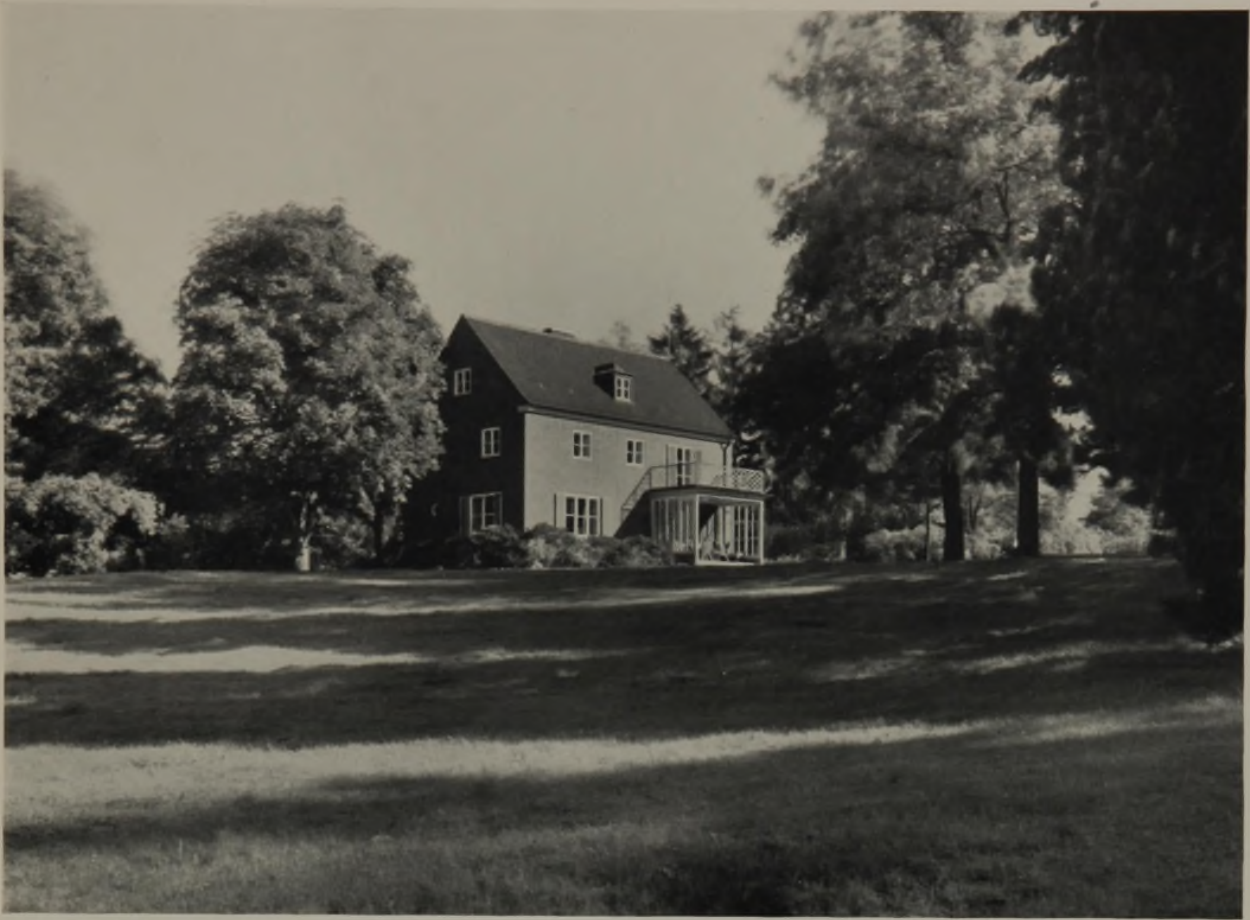
Haus P. in Reinbek-Wentorf. Lage des Baues im Garten
