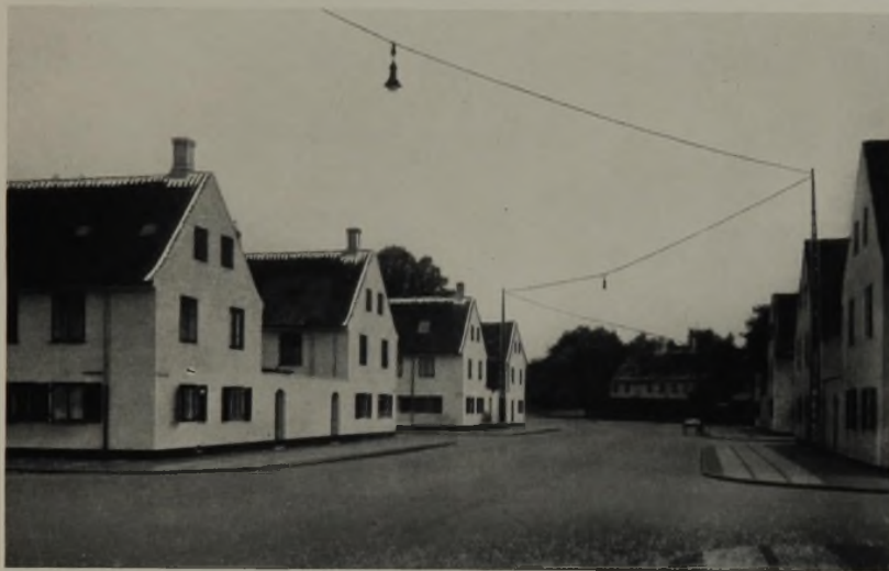
4 Nybodersiedlung. Kopfseiten der Hauszeilen
