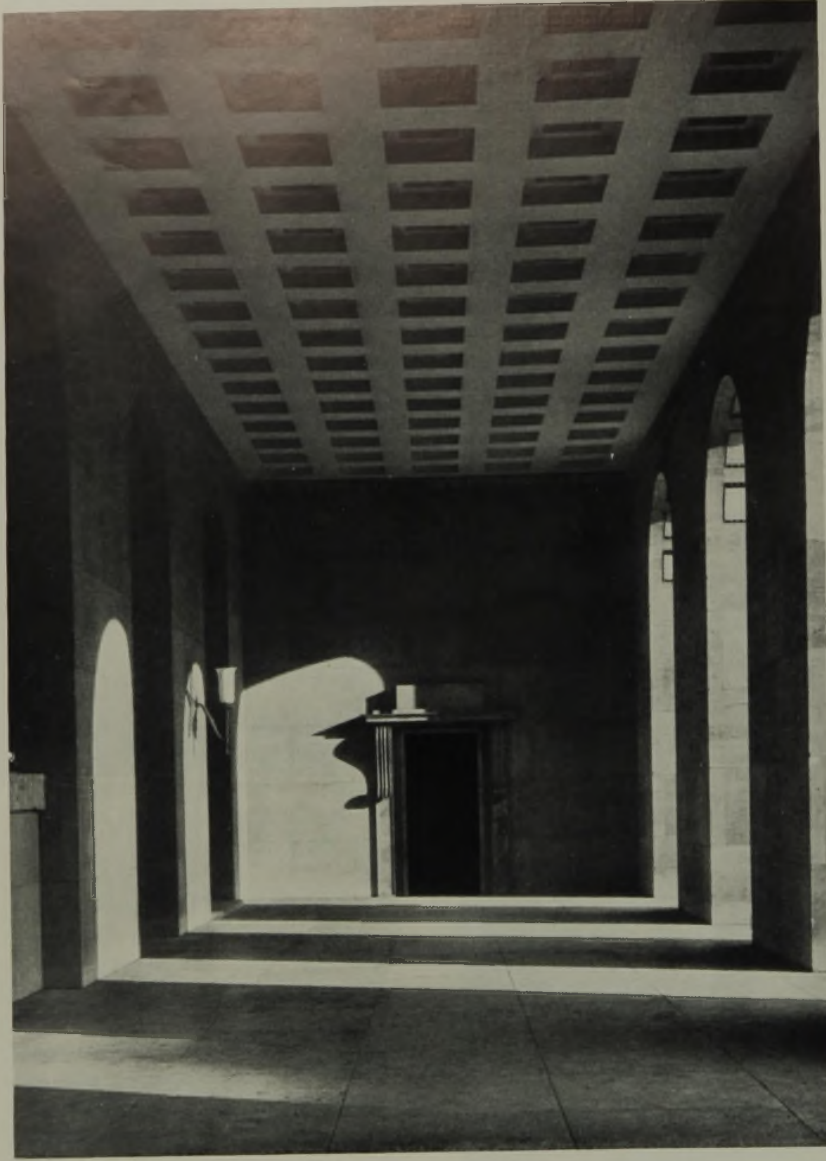
11 Eingangshalle des Polizeigebüdes
