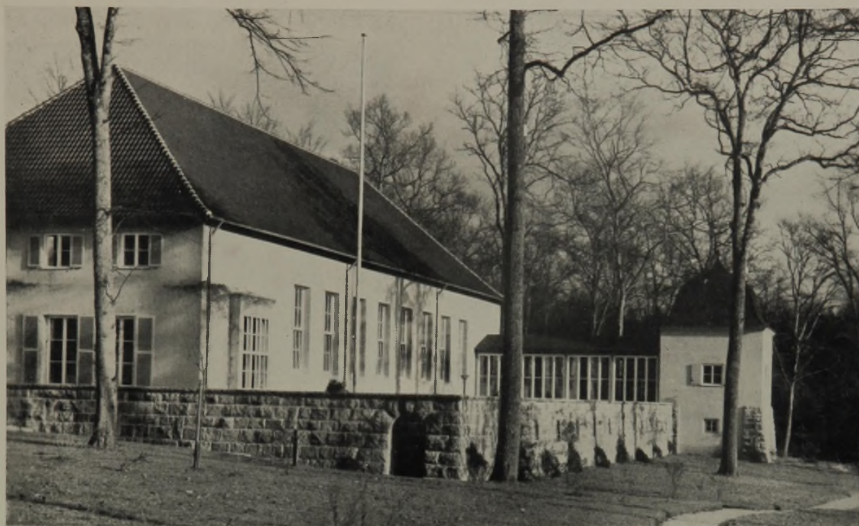
Bild 1. Mauer aus Tuffstein, Wände heller Rauputz, Dach Ziegel. An der Wetterseite Holzläden
