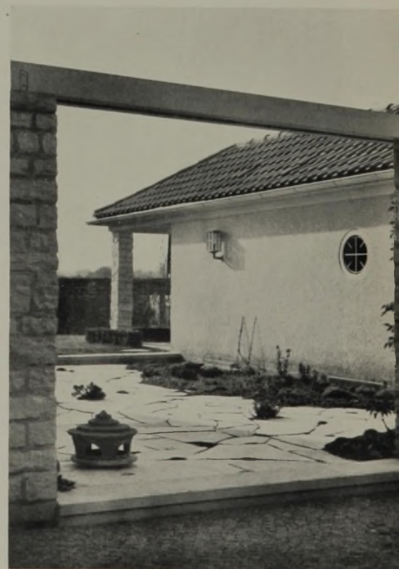
Durchblick von Nordosten zur Garage
