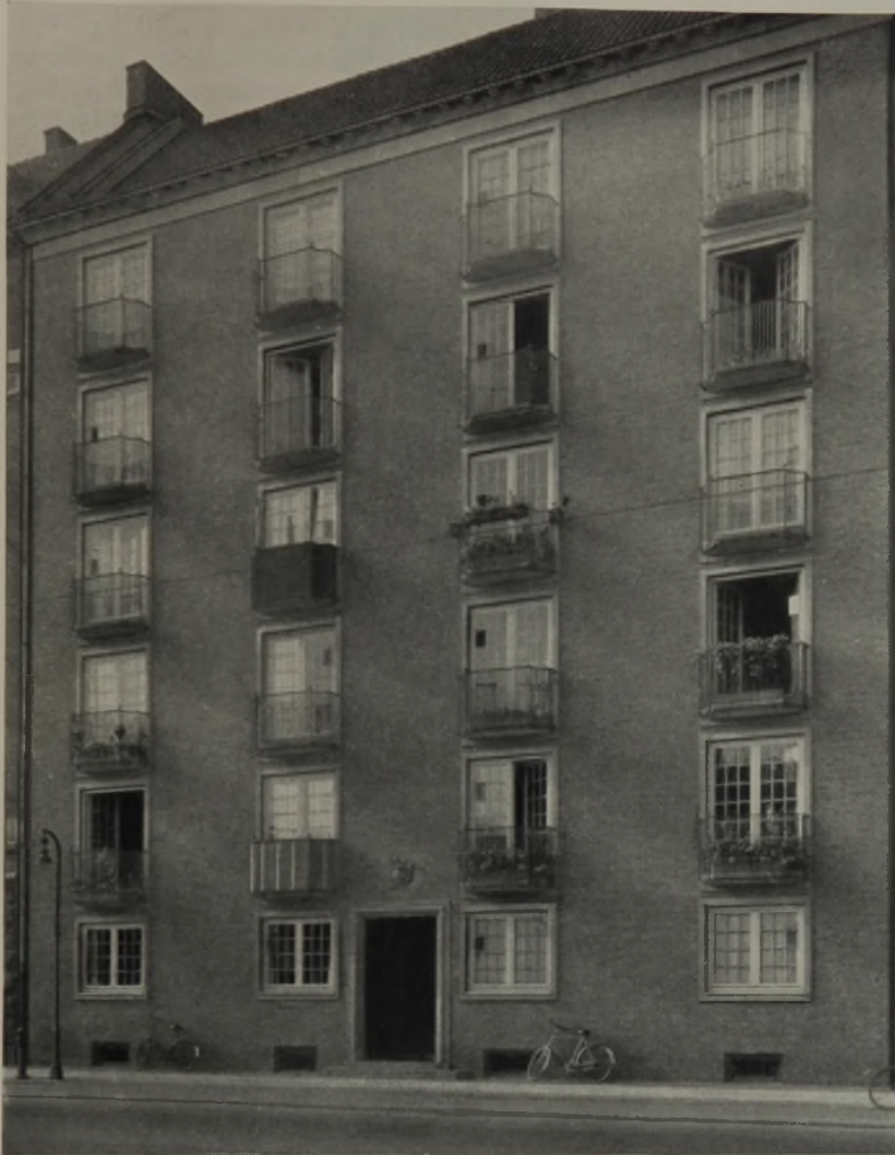
8 Miethaus am Toldbodvej. Roter Backstein. Balkongitter aus Messing
