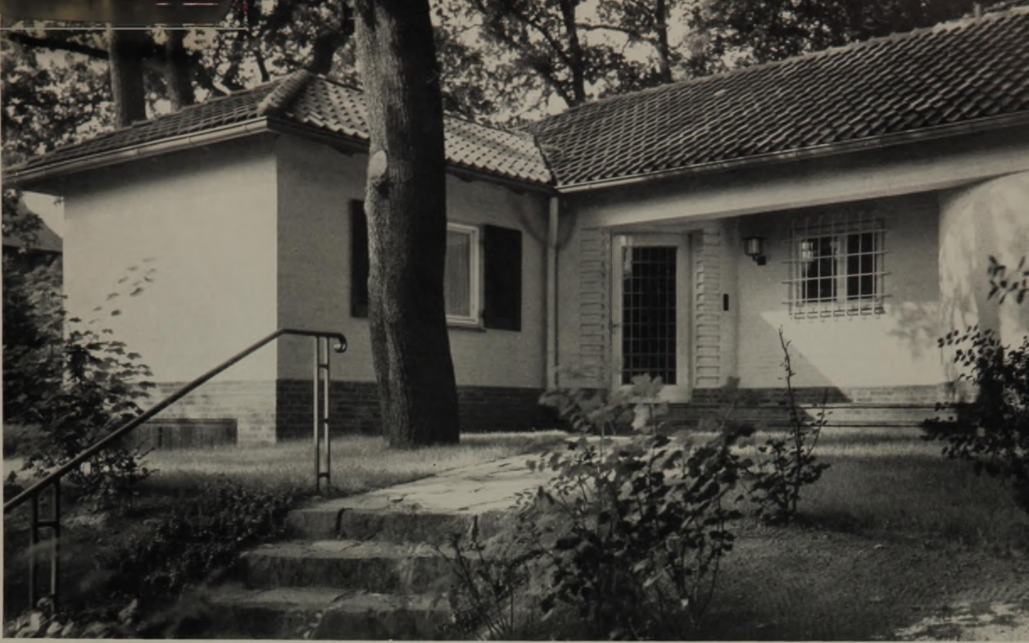
Arzthaus Sch. in Blankenese. Eingangsseite (Blick von Norden)
