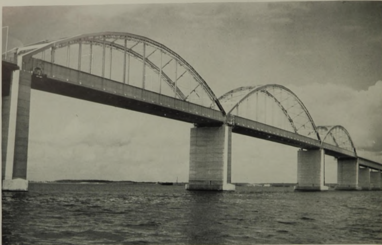
Storströmbrücke. Mittelgurte über den Durchfahrtsöffnungen
