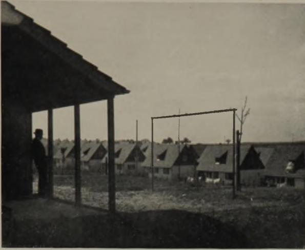
Teilansicht der Siedlung
