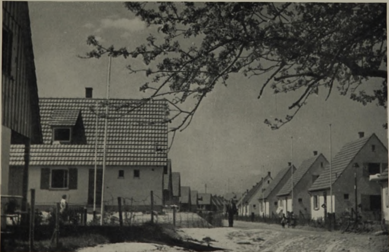
Blick in eine Siedlungsstraße
