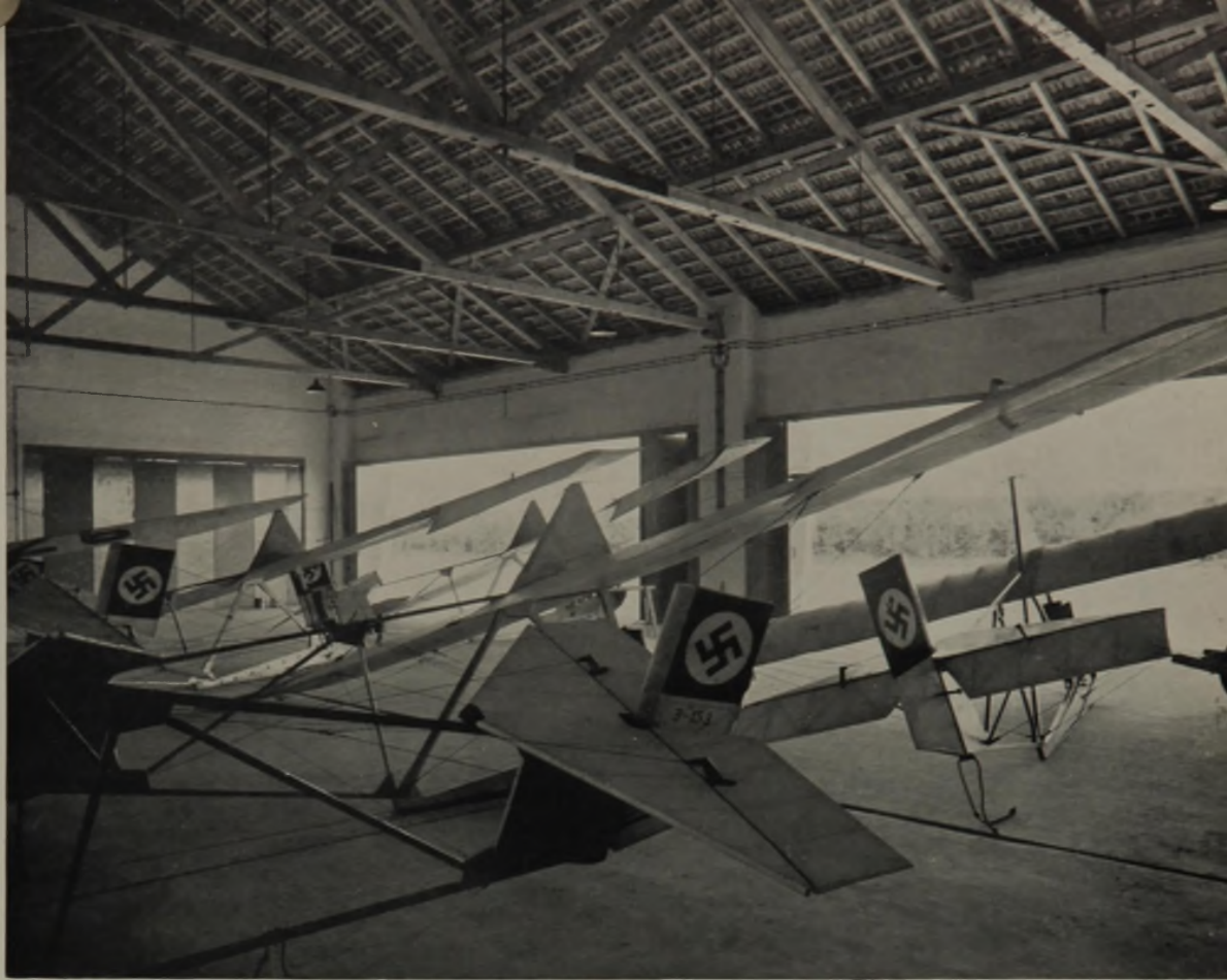
Rechts: Inneres der Flugzeughalle. Unten: Wasch- und Baderaum. Unten rechts: Tischlerwerkstatt im Hallen- gebäude. Aufnahmen: Ernst Scheel, Ham- burg
