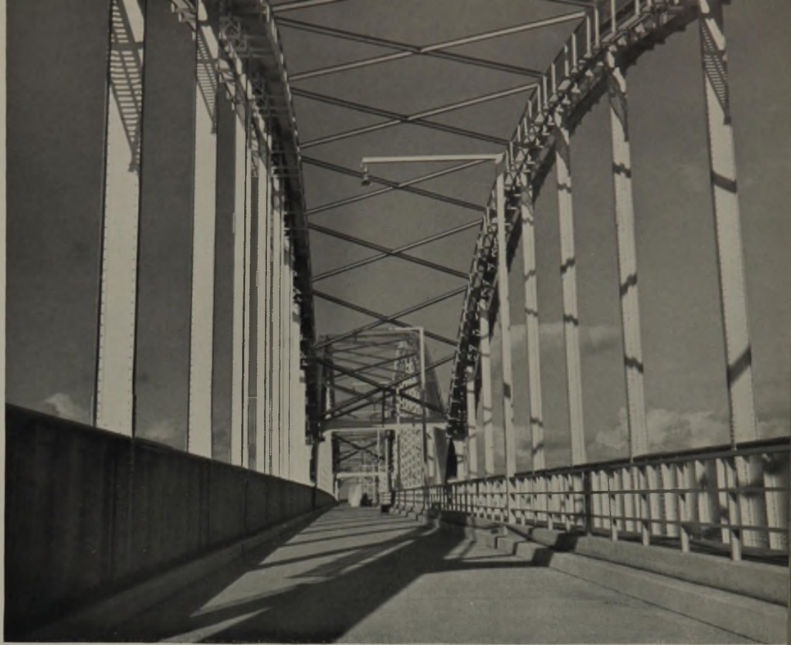
Blick in die Mittelgurte der Brücke
