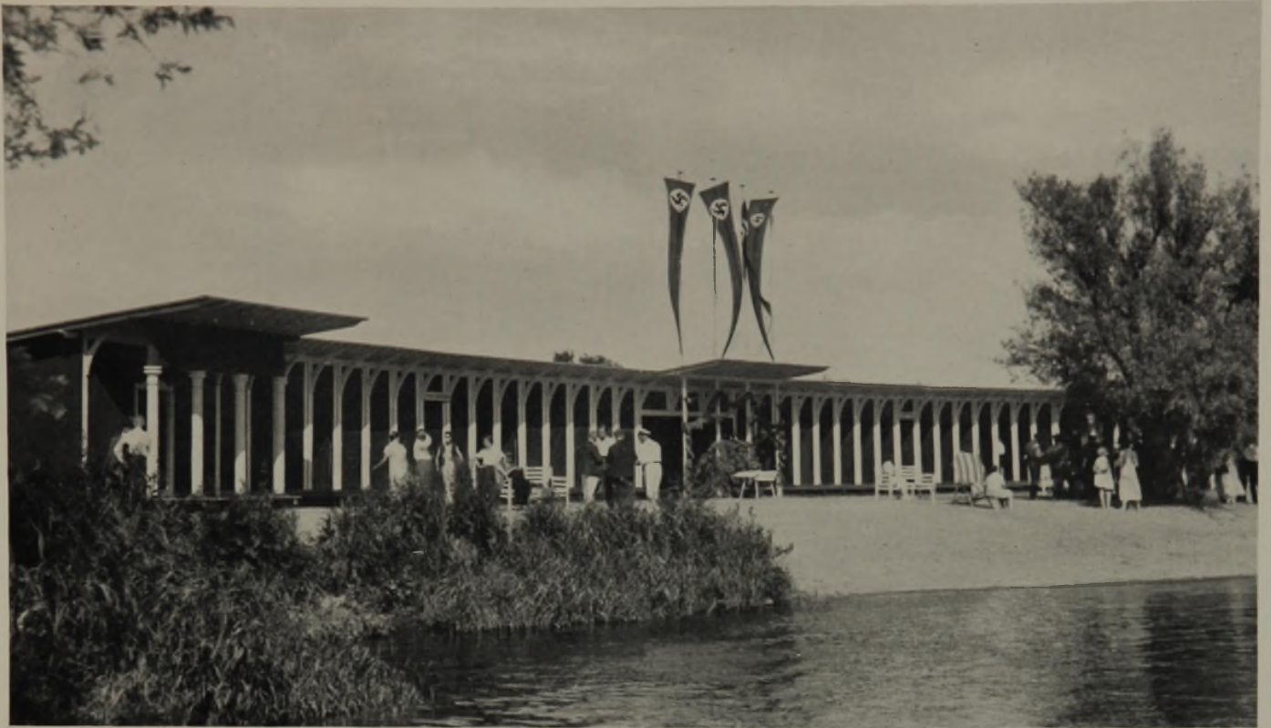
Flußbadeanstalt in Lesum. Gesamtansicht vom Strand
