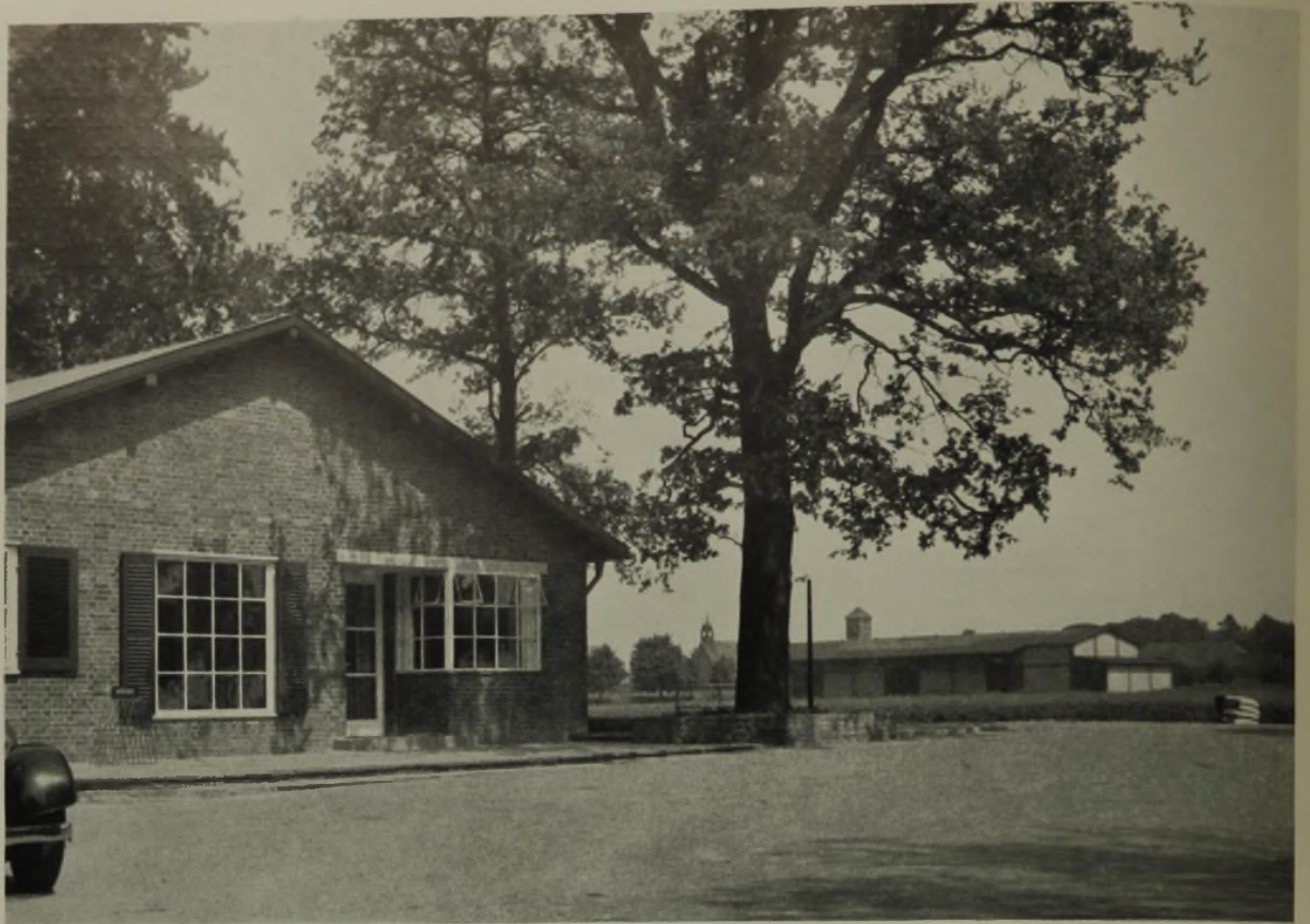
Bürohaus der Werkanlage. Fernsprechvermittlung, Anmeldung und Wartezimmer
