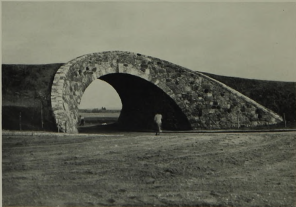
22 Fußgängerbrücke über der Zufahrt zum Parkplatz. Brücke aus Feldsteinen Aufnahmen (3): Fritz Krauskopf, Königsberg, und O. Schnuchel-Friesicke, Berlin
