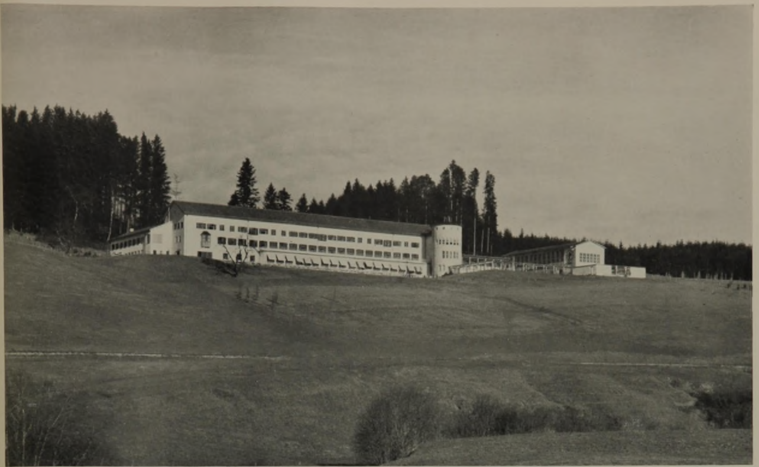
1 Gesamtansicht von Süden. Das Erholungsheim liegt im Schutze eines Hochwaldes. Der Baukörper ist hell verputzt. Dach des Hauptkörpers: Pfannen. Dächer der niedrigeren Liegehallen und des Turmes: Holzschindeln. Oben im Turm ein Glockenspiel Aufnahmen: Lichtbildstelle der Reichsbahndirektion Augsburg
