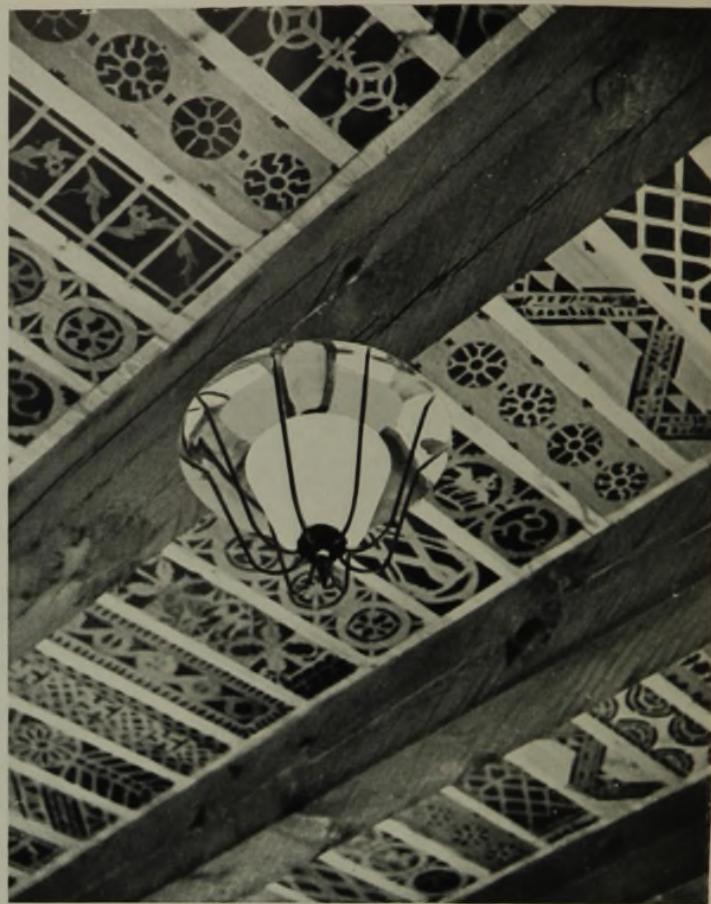
15 Laterne an den Eingängen. Rechts 16: Lampe in der Decke der Gartenhalle, Schmiedearbeit mit Kupferhaube. Schablonendecke von Maler Werner Blasius, Berlin
