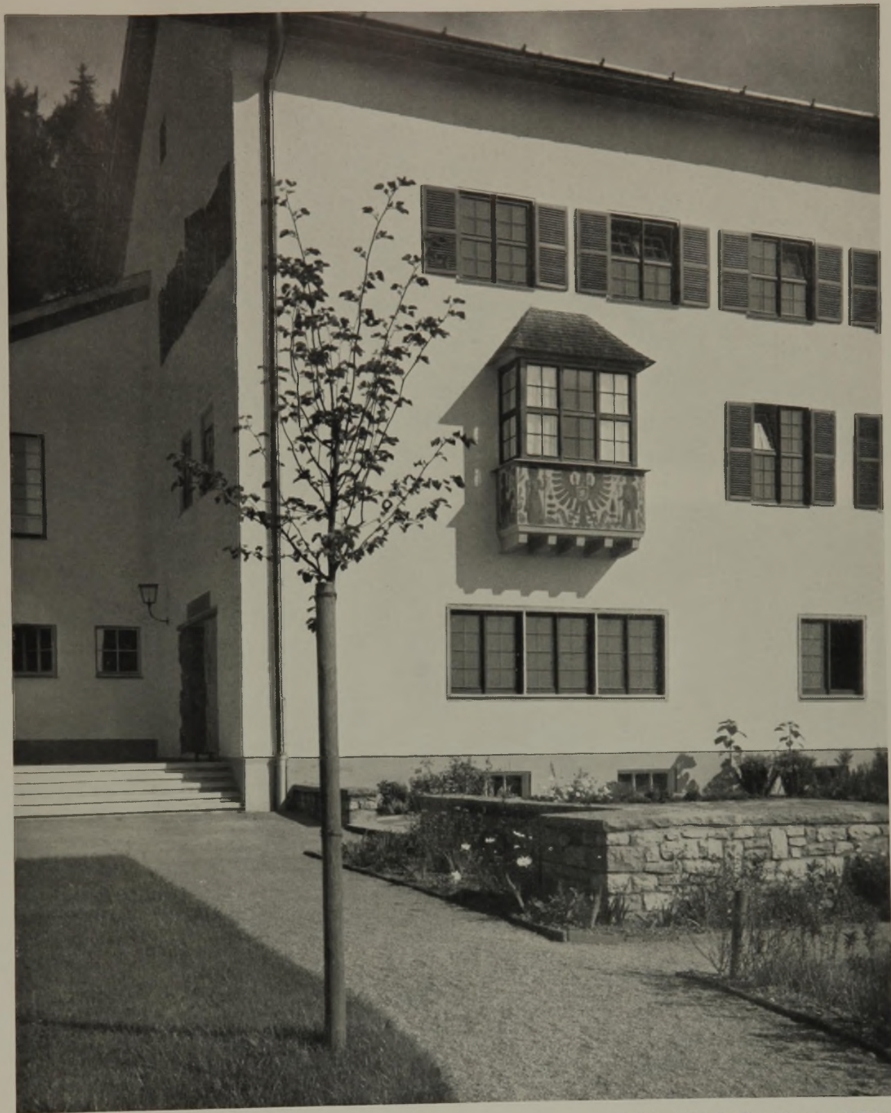
7 Teilansicht des Hauptbaues mit Erker
