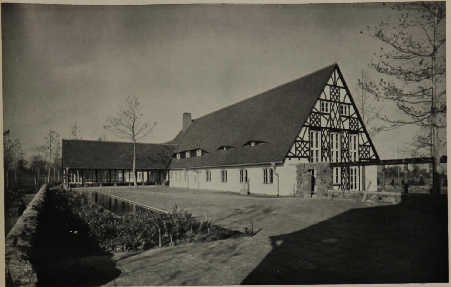
8 Der südliche Gästegarten mit Saalgebäude, Wasserbecken und Staudenbeet. Granitschieferplatten
