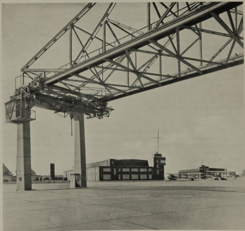
10 Kran für Wasserflugzeuge , im Hintergrund die Hallen
