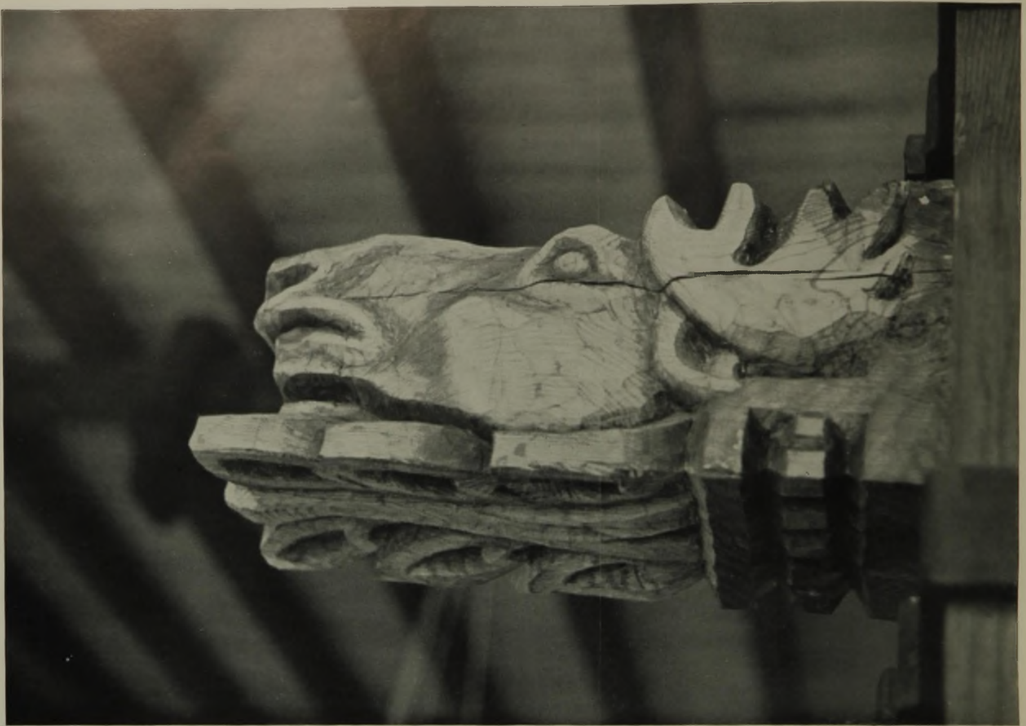
21 Unterzugsende in der Holzkonstruktion des großen Saales, als Elchkopf geschnitzt. Bildhauer Karl Sylla
