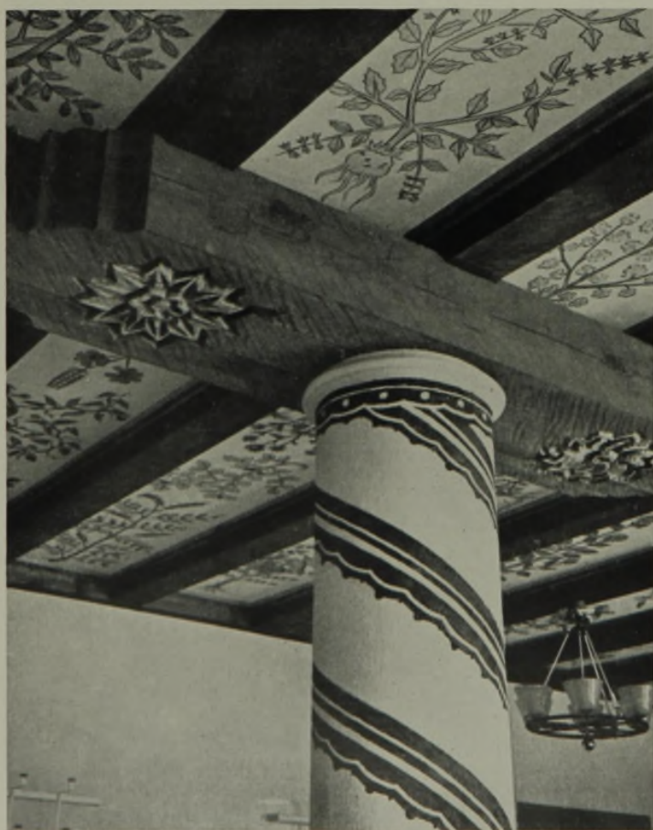
17, 18 Säule mit Kratzputz. Deckenbalken, ferner Konsole im großen Gastzimmer. Malerei: Ostpreußische Pflanzenmotive. Maler W. Blasius. Unterzug beschnitzt von Bildhauer Karl Sylla, Hohenstein
