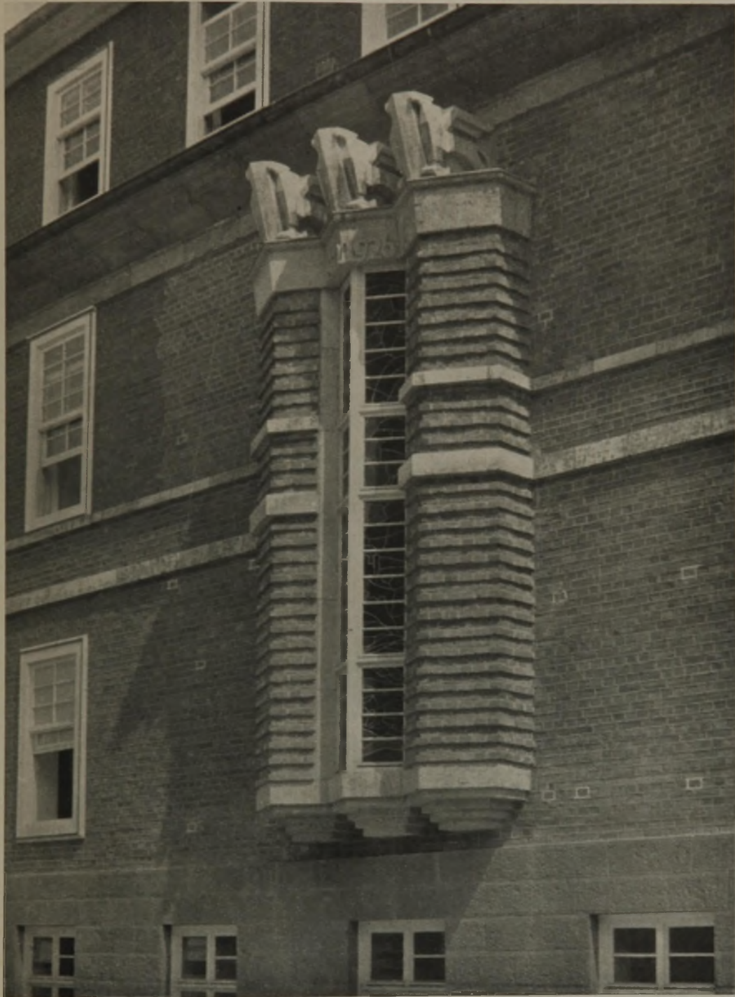
Abb. 7. Erker mit Treppenhaufenster. (Phot. Rich. Ziegler, Düsseldorf.)
