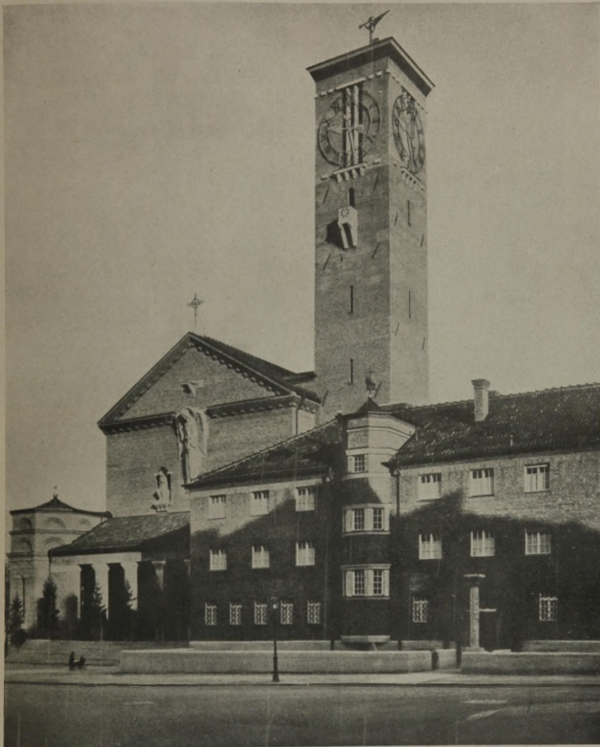
Abb. 4. Hauptfassade von der Schneckenburger Straße aus.
