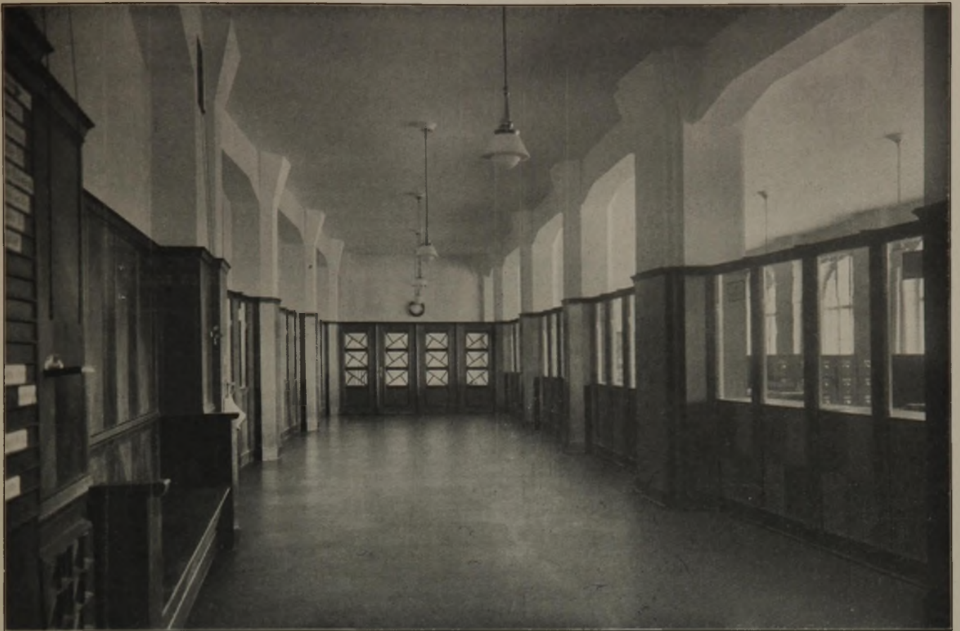
Abb. 12. Blick in die Abfertigungshalle für das Publikum.
