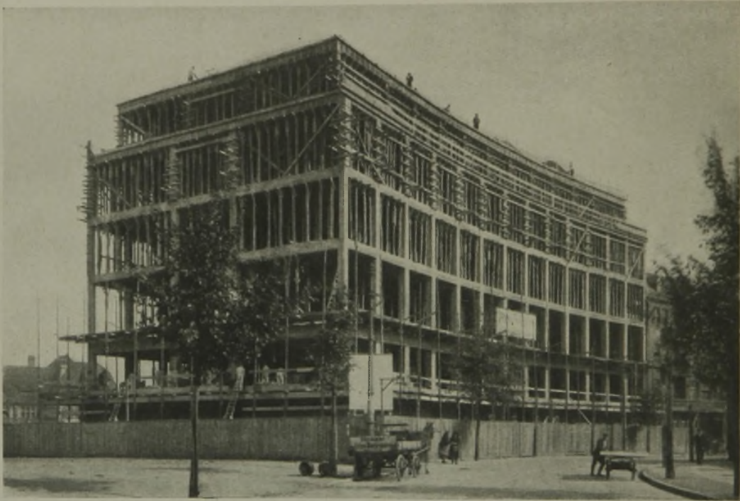
Abb. 14. Eisenbetonkonstruktion der Allgemeinen Ortskrankenkasse in Danzig.
