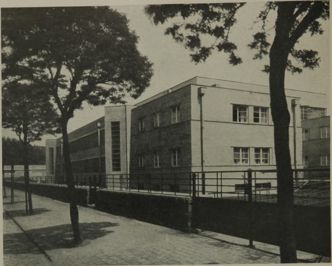
Abb. 24. Städt. Umformer-Werk in Dresden-Neustadt. Neueste Arbeiten des Dresdner Stadtbaurates Wolf.
