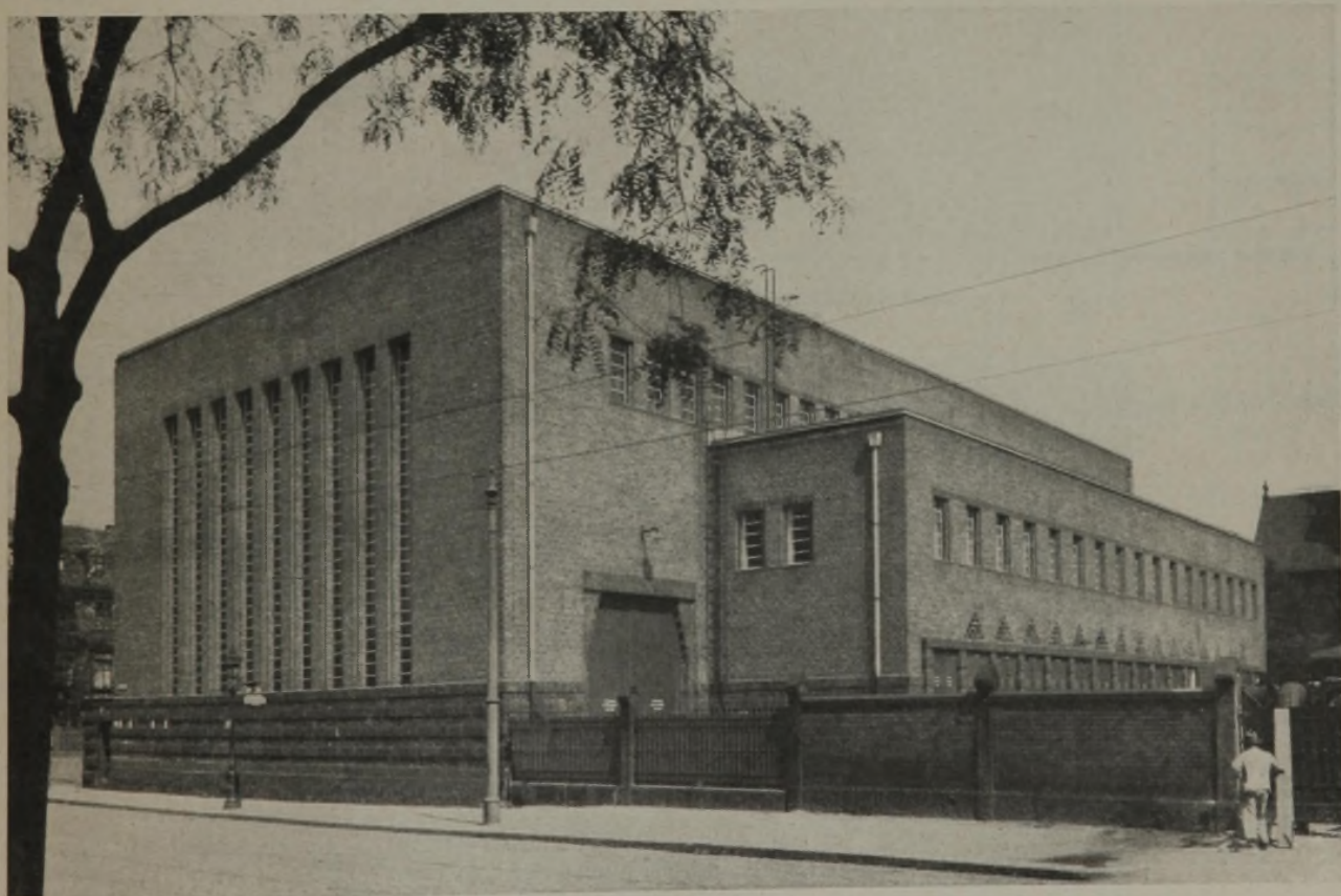
Abb. 16. Phasenschieberhaus im Städt. Westkraftwerk zu Dresden. (Phot. P. Georg Schäfer, Dresden-A.)
