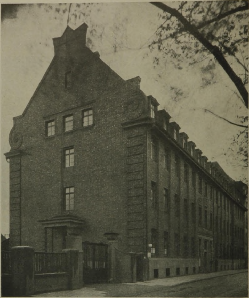
Abb. 11. Gesamtansicht vom Postgebäude in Düsseldorf-Oberkassel.
