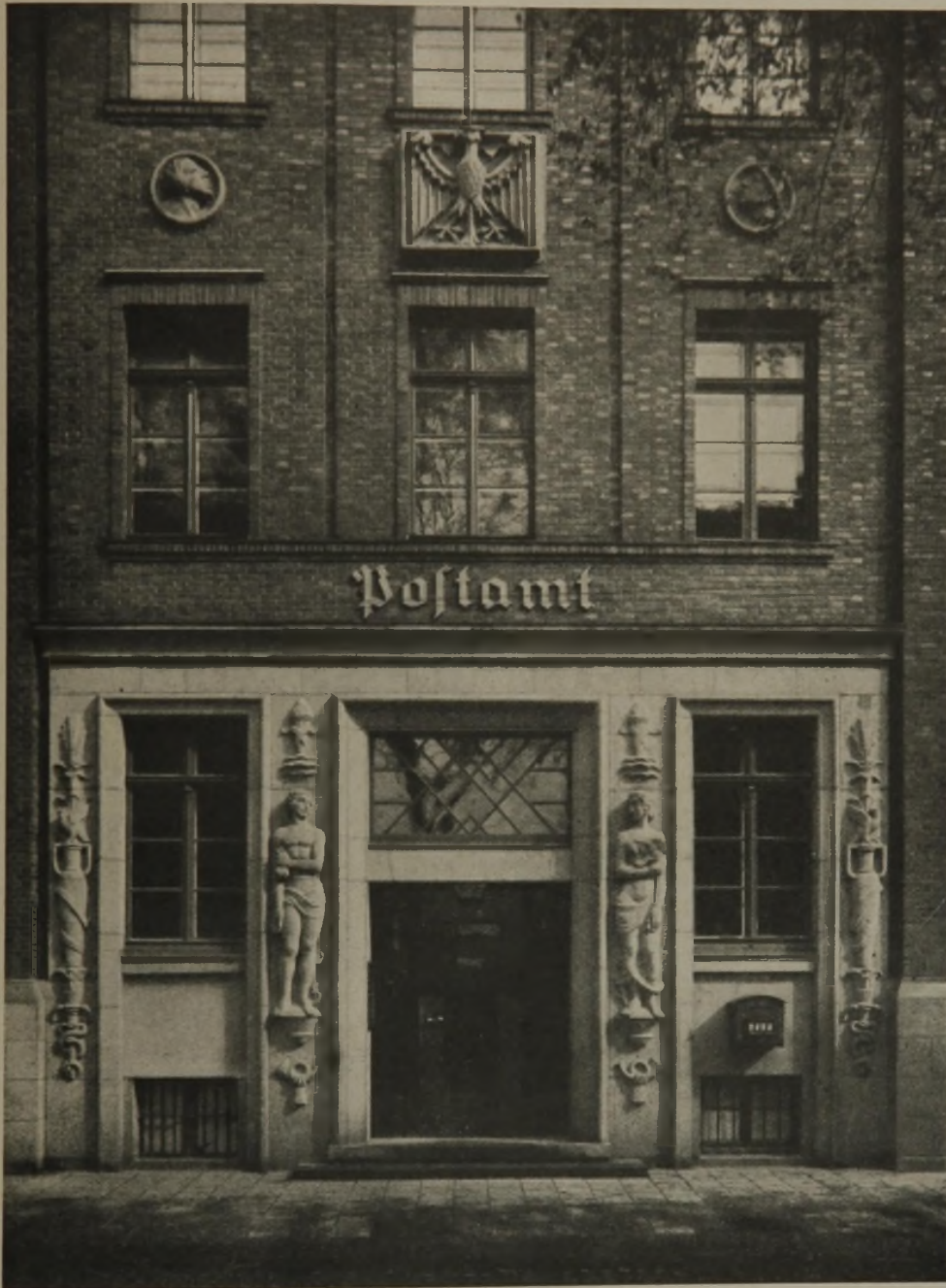
Abb. 13. Eingang zu den Schaltern im Postgebäude Düsseldorf-Oberkassel.
