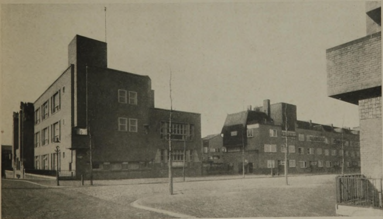
Abb. 1. Amsterdam, Mittelschule an der P. L. Takstraße. Entwurf Stadtbauamt; rechts Wohnhausblöcke. Arch. de Klerk.
