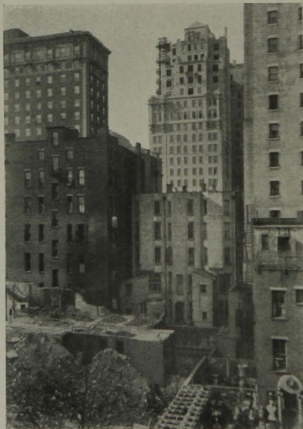
Abb. 9 (rechts). Blockinneres mit Baustelle. Sexington-Avenue, 57. Str., Madison-Avenue, 56. Str. N. Y. C.
