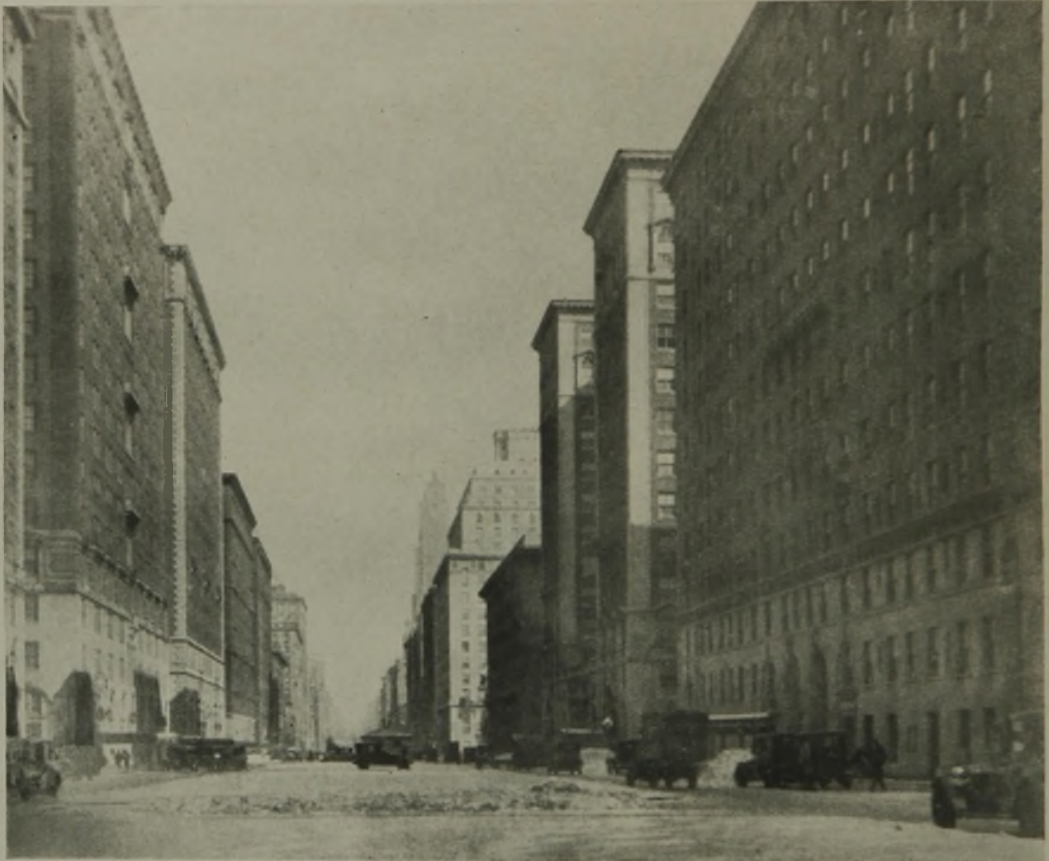
Abb. 1. Park-Avenue, Blick von der Grand Centralstation nach Norden.
