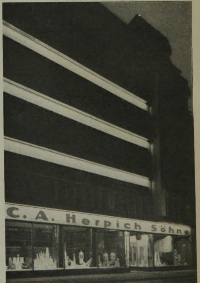
Abb. 9 u. 10. Soffitenbeleuchtung der Brüstungen von oben. Die Lampen sind in Metallgesimsen eingebaut.
