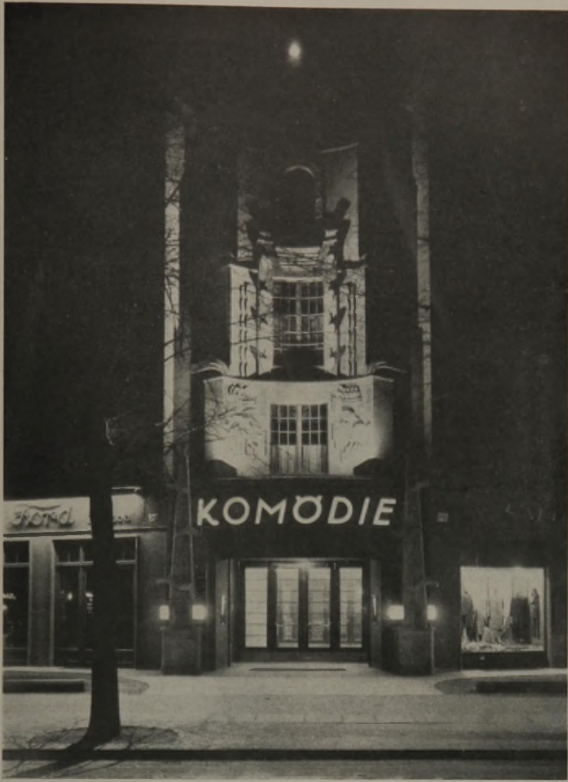
Abb. 5. Anleuchten der Fassade mittels Scheinwerfer.
