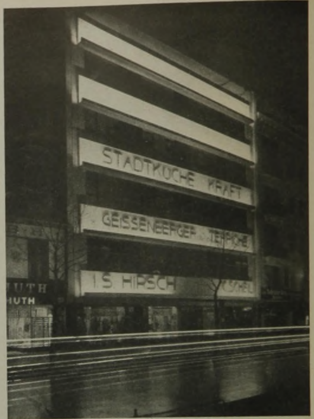
Abb. 7 u. 8. Fassade nach dem Reklametafelprinzip. Soffitenbeleuchtung von unten.
