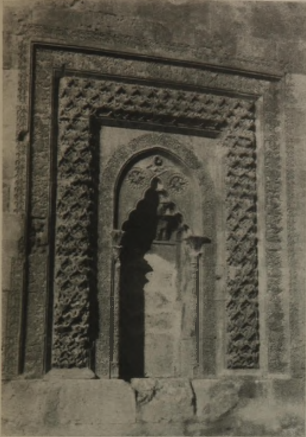
Abb. 6. Vermauertes Nischenfenster u. Fassade
