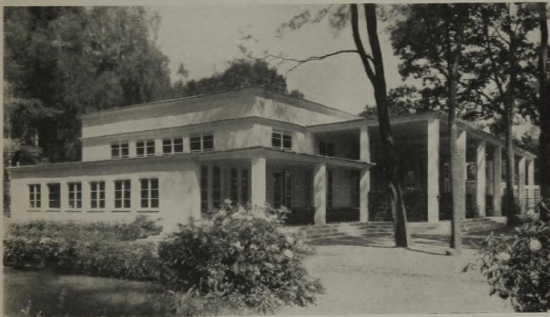
Abb. 8. Hauptrestaurant. Architekt Robert Günther, Liegnitz.
