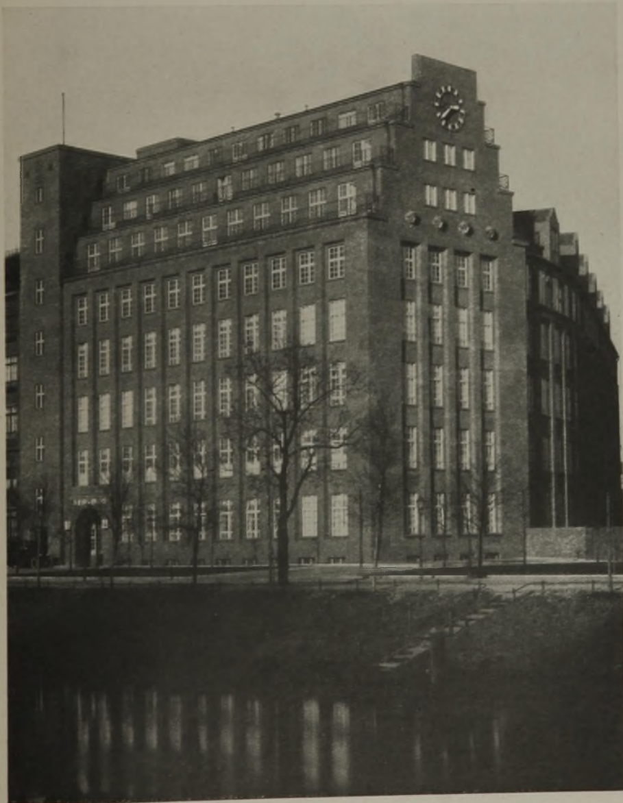
Abb. 1. Hauptansicht vom Salzufer aus.
