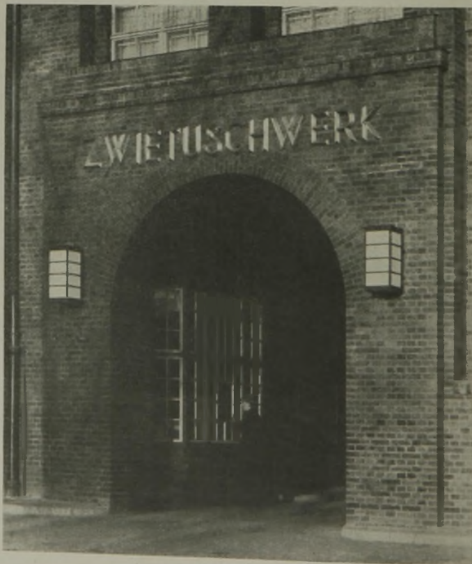
Abb. 10. Eingang am Salzufer.
