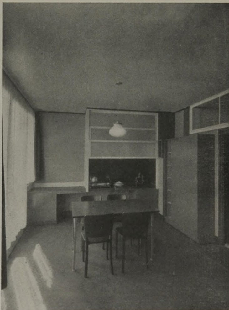
Abb. 4 (oben). Küche im Haus von Arch. Lud. Hilberseimer, mit beiderseitig verschließbarer schrankumbauter Durchreiche.
