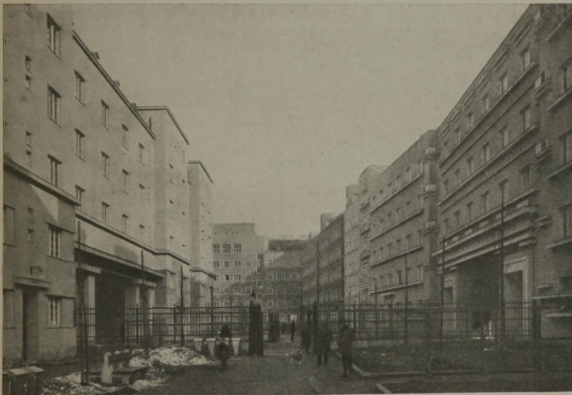
Abb 5. Links der Komplex Behrens als klarer äußerer Ausdruck des inneren Grundrißschemas, rechts Prof. Hoffmanns Werk, das sich im äußeren Ausdruck in einer eigenartigen, wenn man will „Plattenromantik“ ergeht, die in natura durch die gelbe Flächentönung noch stärker in Wirkung tritt
